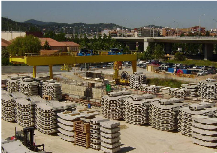
Figura 4.3 Vista de zona de acopio y descarga
