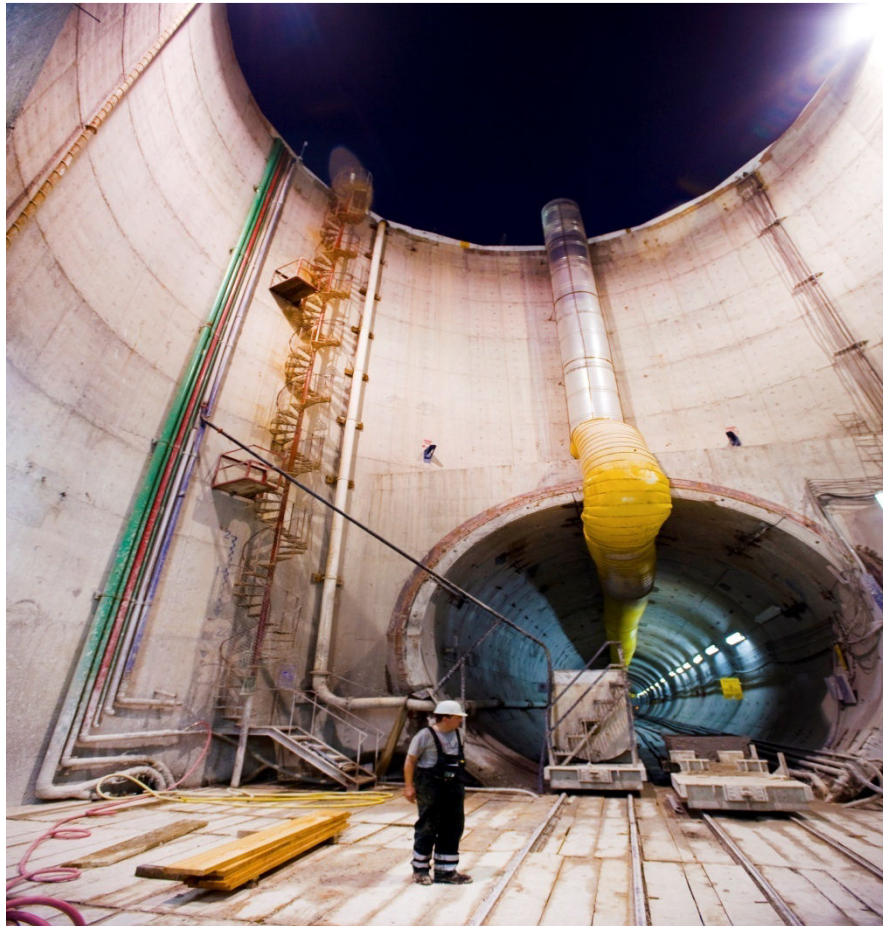
Portal de entrada en la Lumbra "0" (Proyecto: Túnel Emisor Oriente, México).
