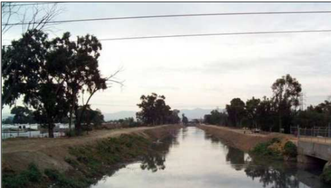
Foto 3.1 Canal abierto de aguas negras “Rio de los Remedios”, estado actual.
