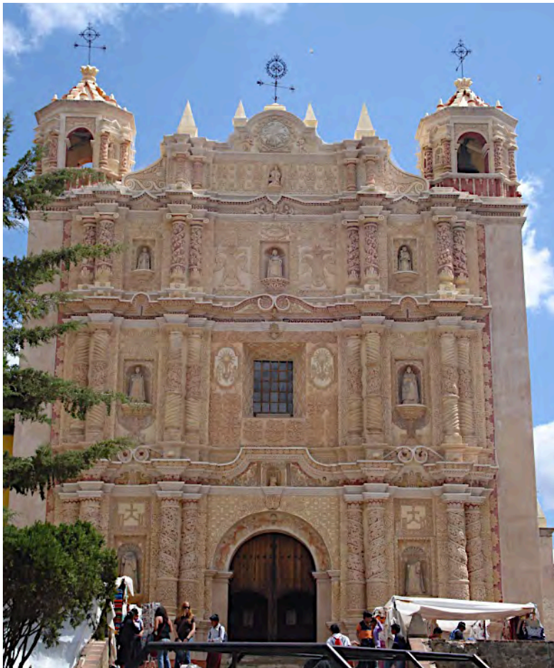
129. Fachada actual del templo de Santo Domingo de Guzmán en San Cristóbal de Las Casas. Foto: JFGC.
