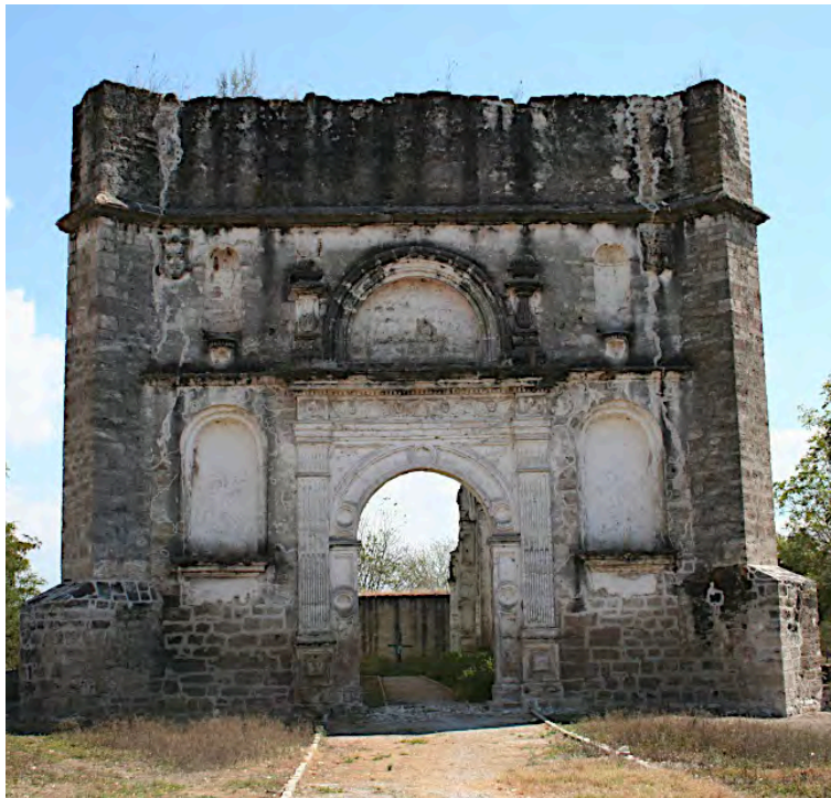
66. Fachada del templo de San Vicente Ferrer en Copanaguastla, posterior a las intervenciones. Foto: JFGC.
