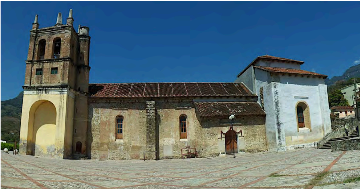
59. Templo y convento de San Vicente Ferrer en Copainalá, Chiapas; es probable que el edificio arquitectónico ubicado a la derecha de la fotografía, funcionara como capilla abierta. Foto: JFGC.
