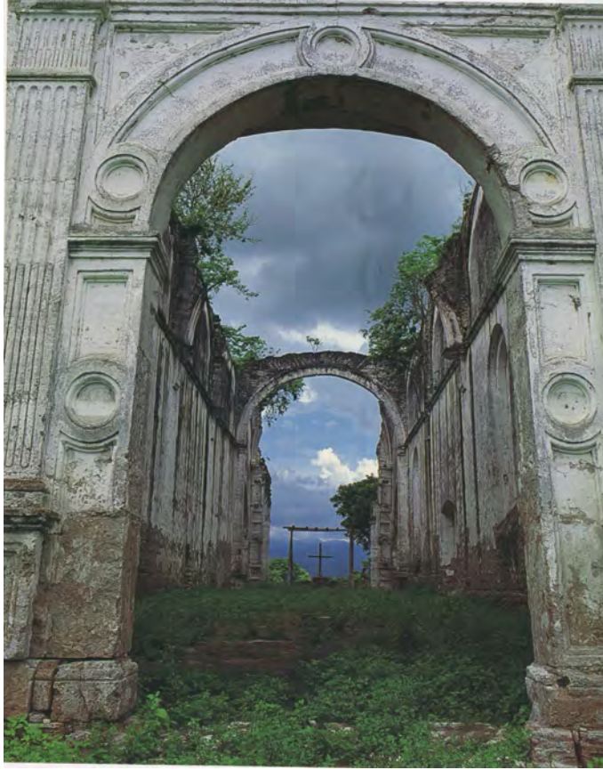
65. Interior de la nave del templo de Copanaguastla, antes de las intervenciones en su arquitectura. Artigas (2000), p. 10.
