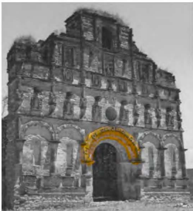
79. Arco con sincretismo en la fachada del templo de Coneta. Foto: JFGC.
