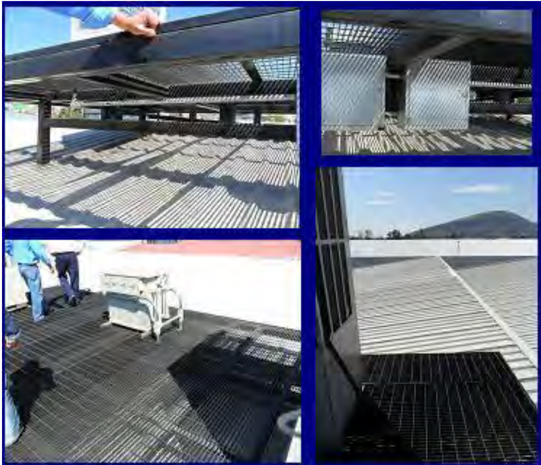
Capítulo 4 Imagen 10 Base de la estructura
