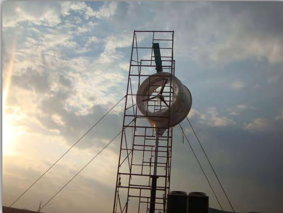
Capítulo 4 Imagen 14 Izamiento del aerogenerador
