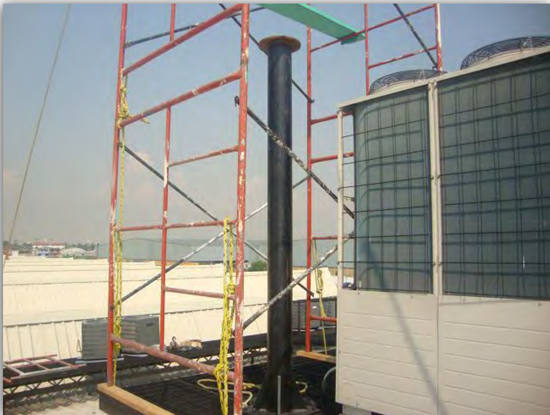
Capítulo 4 Imagen 13 Estructura del andamio
