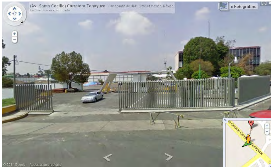
Capítulo 4 Imagen 1 Oficinas CFE-PAESE Tenayuca Fuente: www.google.maps
