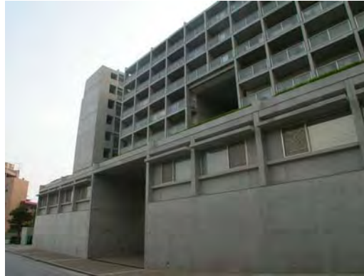
Acceso a conjunto de viviendas Rokko III
