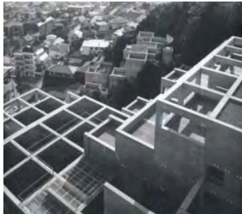
Vista aérea del conjunto de viviendas Rokko II
