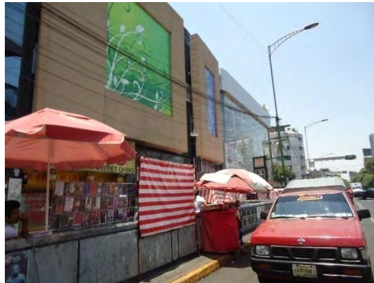
03. La fachada acristalada fue cubierta por un muro falso. Varios Comercios en planta baja
