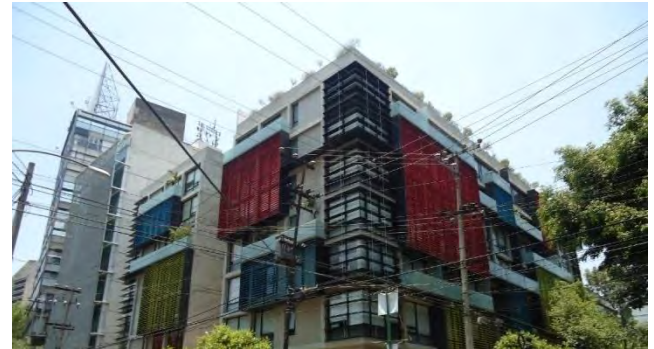
Cableado sobre la calle
