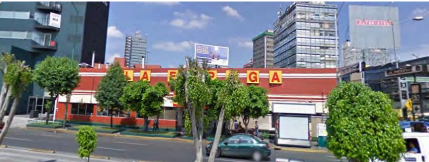
Fachada desde Av. De los Insurgentes
