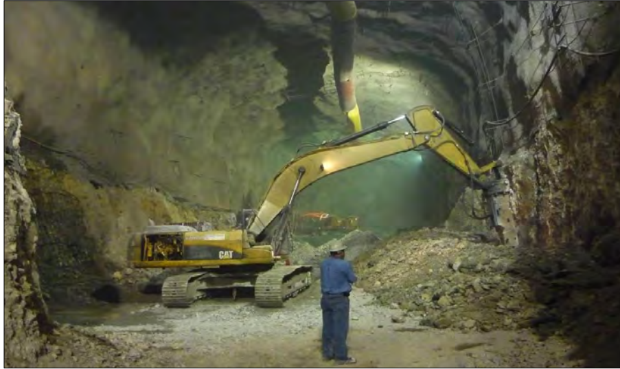
Figura 2.56.- Retroexcavadora utilizada en el proceso de perfilamiento de las paredes en la caverna de la galería de oscilación.
