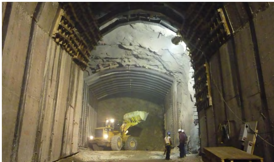
Figura 2.57.- Cargador frontal CAT 966, utilizado en el proceso de retiro de material para la construcción de la bóveda de la galería de oscilación.
