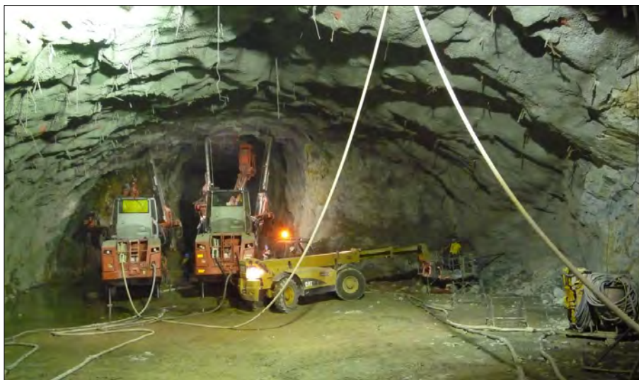
Figura 2.53.- Equipo utilizado en el proceso de excavación de banqueros y fosos de turbina.
