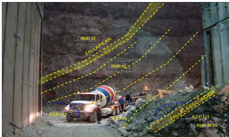
Figura 2.120.- Replicas entre las fallas Pilar y Escondida.
