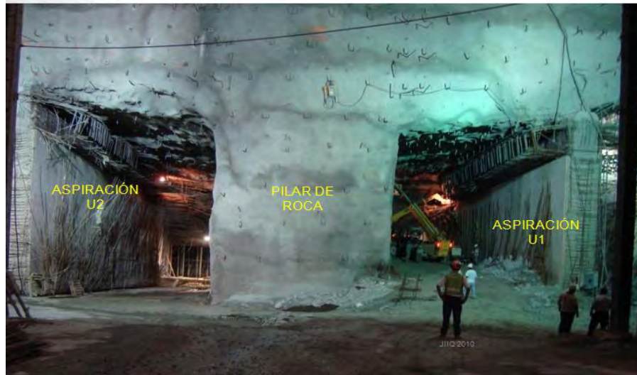
Figura 2.125.- Estado final de la excavación donde se muestra el ancho real del pilar de roca entre los túneles de aspiración.
