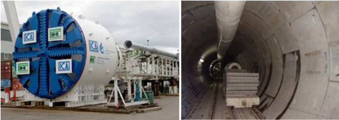
Imagen 16.- Excavación con Tunnel Boring Machine y dovelas
