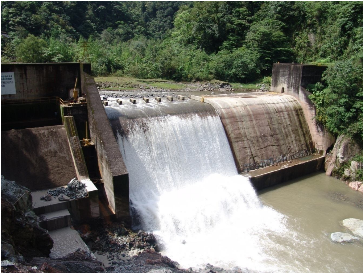
Imagen 9.- P.D. Atexcaco, Estado de Puebla. Presa vertedora
