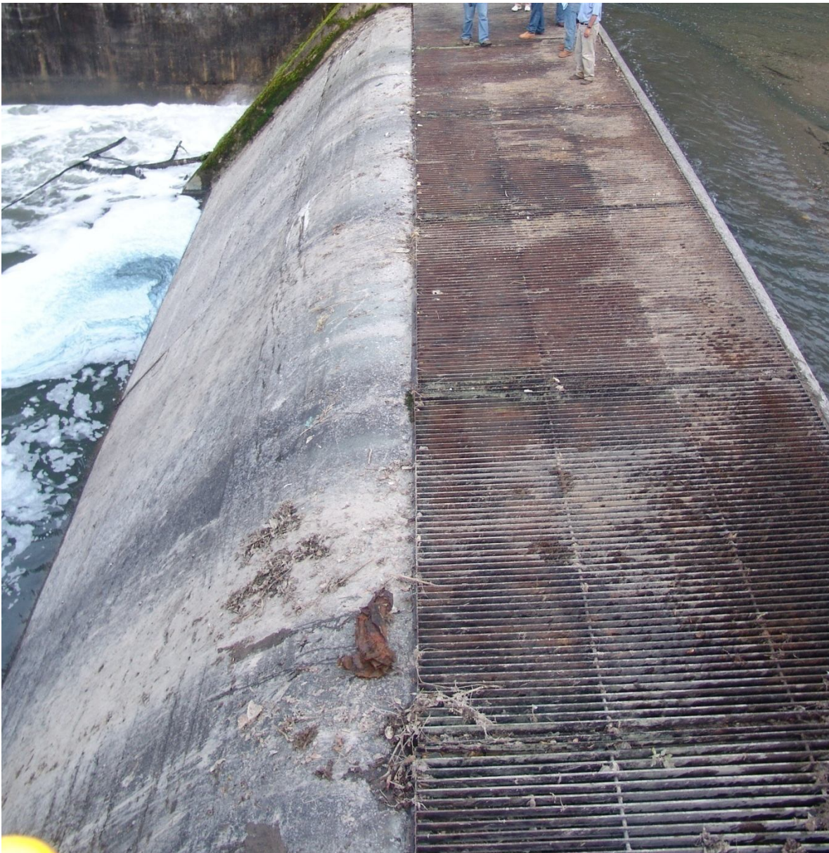
Imagen 6.- P.D. Calapa, Estado de Puebla. Presa rígida tipo “Alpina”
