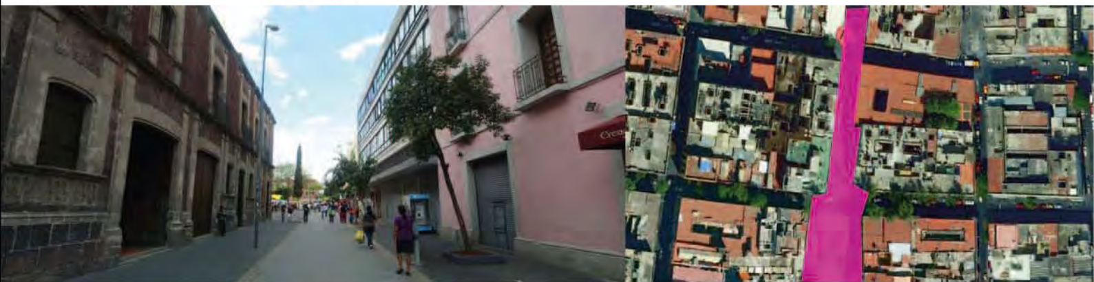
FACHADA PONIENTE // SOBRE CALLE TALAVERA // ESQUINA CON REPÚBLICA DEL SALVADOR
