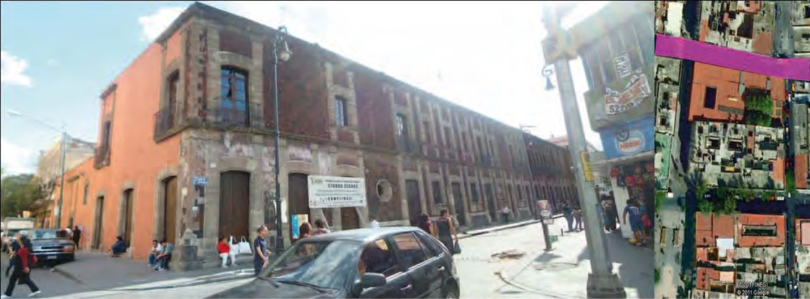
FACHADA NORTE Y ORIENTE // SOBRE REPÚBLICA DEL SALVADOR // ESQUINA CALLE ROLDÁN
