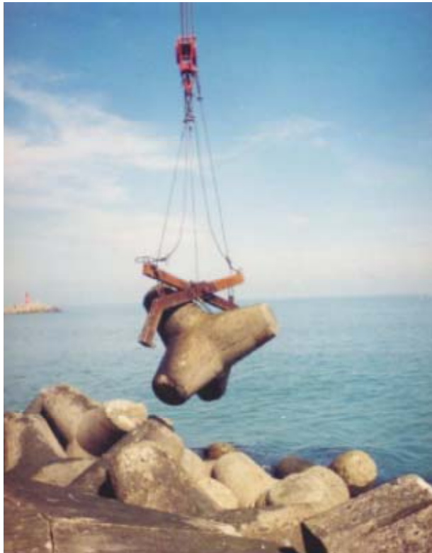
Figura 2. 10. Colocación de tetrápodos.
