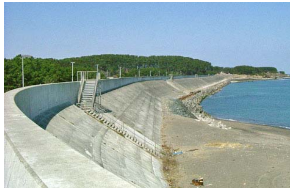
Figura 1. 11. Seawall en Japón.
