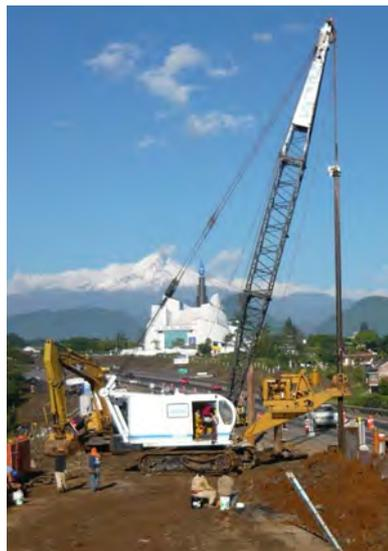
**FOTO 3.1 PRIMER PLANO DE GRÚA EQUIPADA CON PERFORADORA.**
