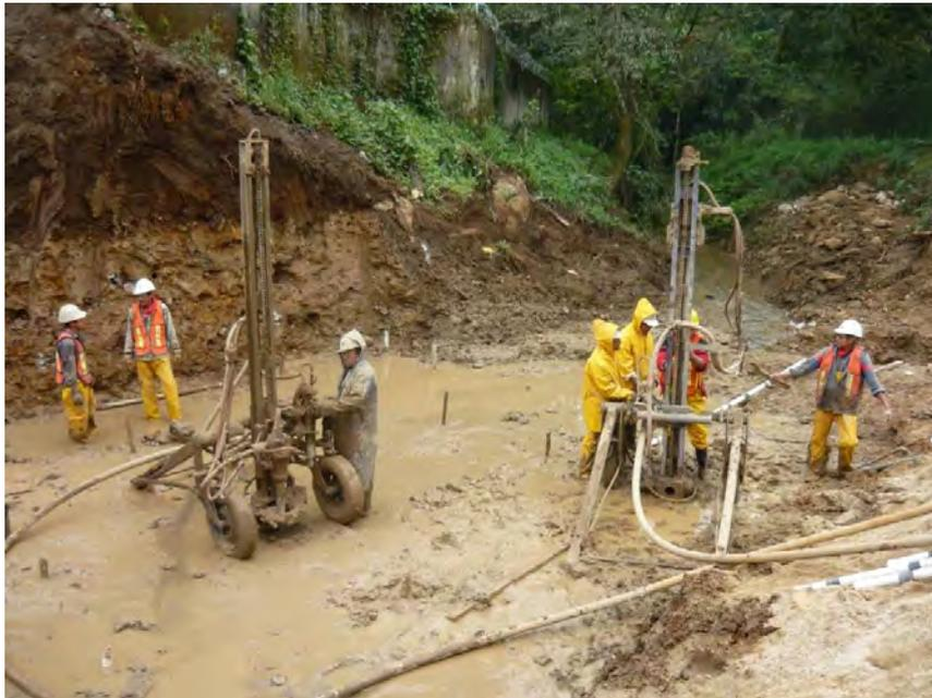
**FOTO 3.4 TRABAJOS DE PERFORACIÓN PARA INCLUSIÓN DE LECHADA.**
