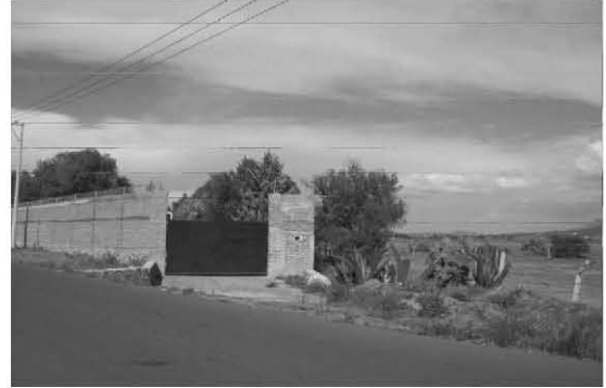
Fotografía 2 (vista desde la carretera)
