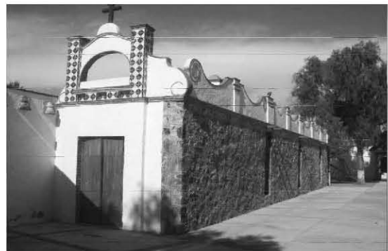
Fotografía 10 (vista exterior de la capilla)
