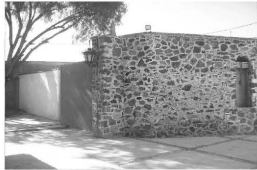
Fotografía 8 (vista de el area de instalaciones y serv.)
