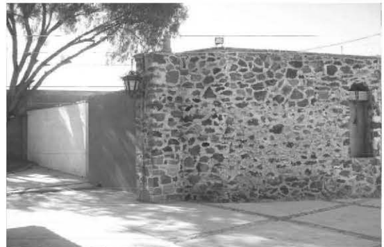
Fotografía 8 (vista de el area de instalaciones y serv.)
