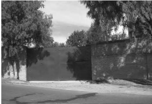
Fotografía 1 (vista desde la carretera)
