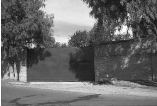
Fotografía 1 (vista desde la carretera)
