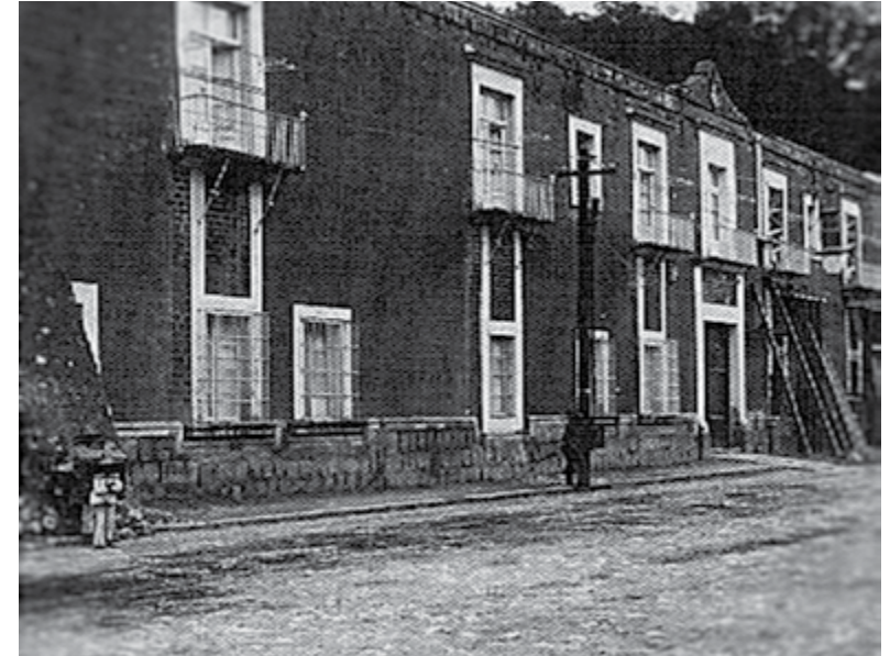
Fachada de la Casa de la Bola antes de su restauración en 1914
