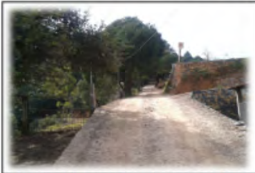
VISTA DEL CAMINO DE TERRACERÍA PARA ACCEDER AL TERRENO.
