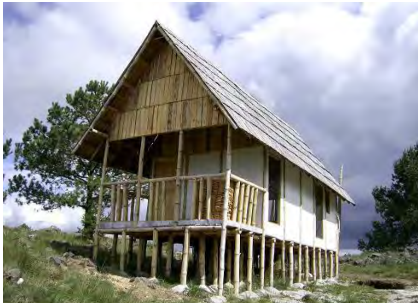
Imagen 4.14 Vivienda construida a partir de bambú, madera y bambucreto realizada en la comunidad de Tlacotalpa, Ejido de Chignautla, Puebla.
