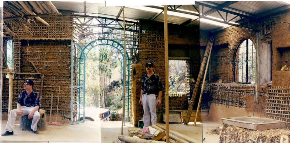
Imagen 4.17 Construcción de la casa del profesor Clinton McDowell Chenoweth, con la técnica del Bahareque, en Tepoztlán Morelos.
