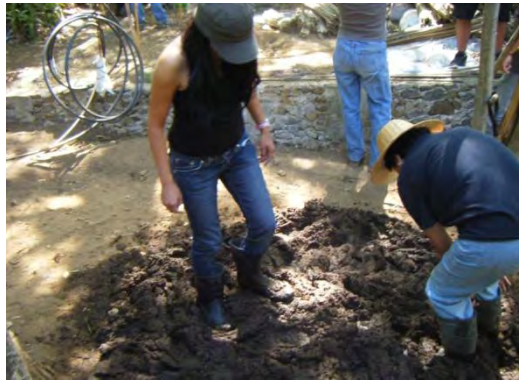
Imagen 4.21: Mezcla de materiales para el relleno de la estructura o rejilla de bambú.
