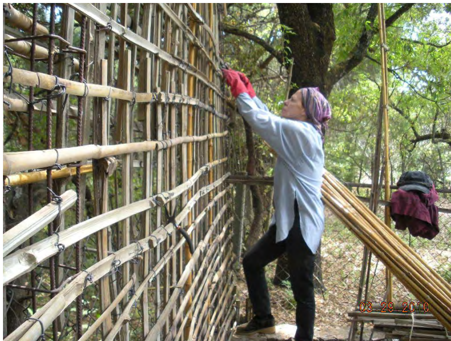
Imagen 4.18 Inicio en la construcción del muro, técnica Bahareque.
