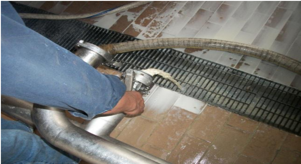
Figura.-43 Drenado de tubería, planta Liconsa Norte. Fotografía tomada con permiso de la administración (22 de septiembre 2012)
