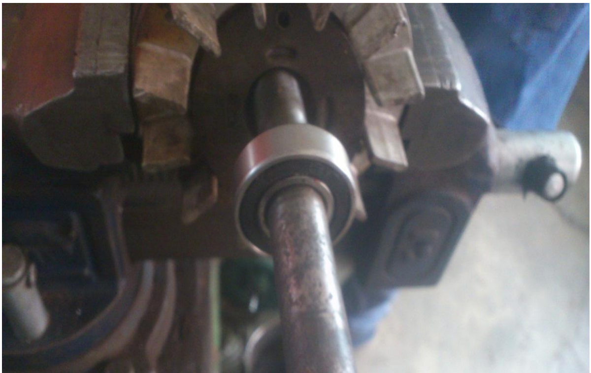
Figura 63.- Colocación del balero nuevo, planta Liconsa Norte. Fotografía tomada con permiso de la administración (22 septiembre 2012).
