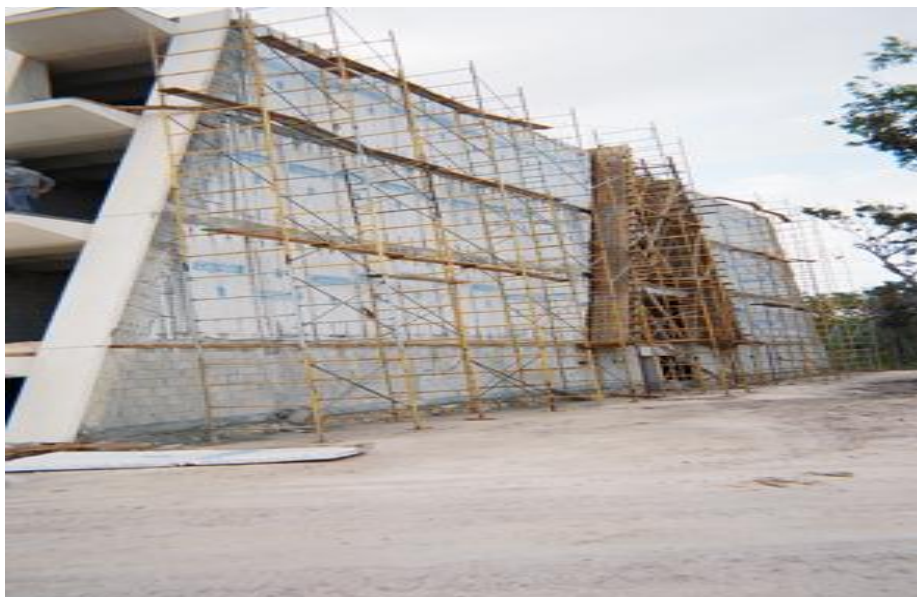
Figura No. 17. Se observa el andamio para la colocación del panel como muro divisorio.
