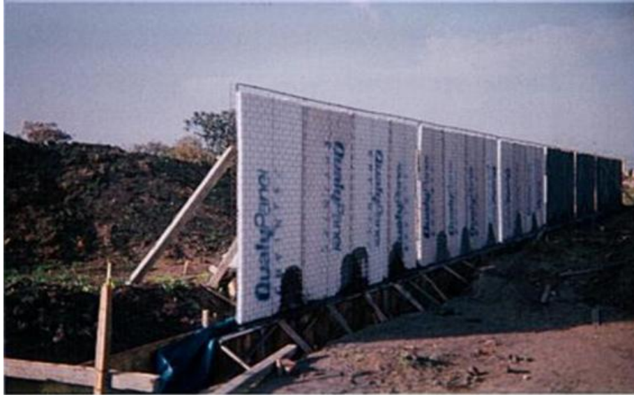
Figura No. 18. Estucado de un muro de acometida (fachada).
