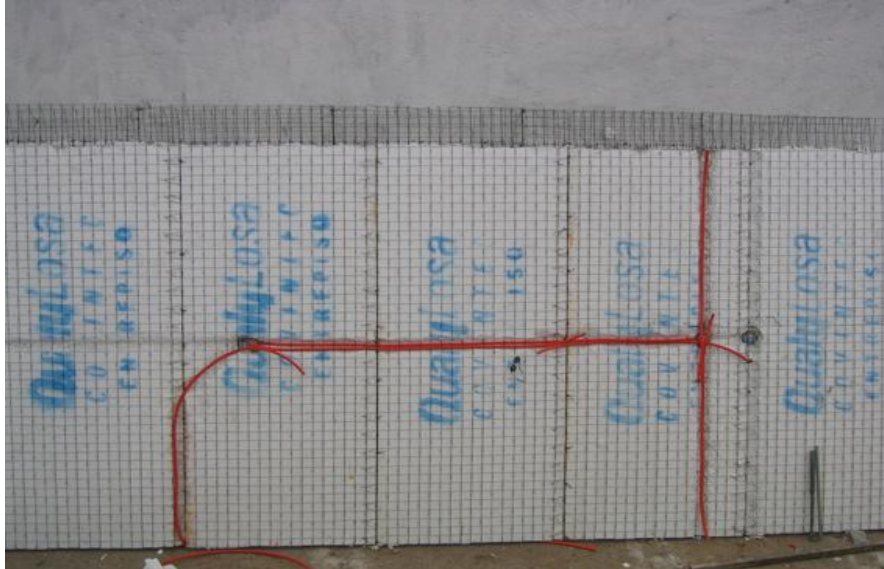
Figura No. 38. Empotramiento de manguera para la instalación eléctrica.
