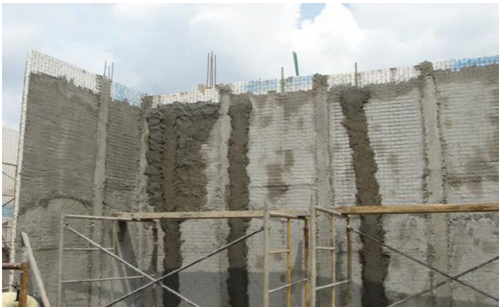
Figura No. 15. Aplanado interior en muros.
