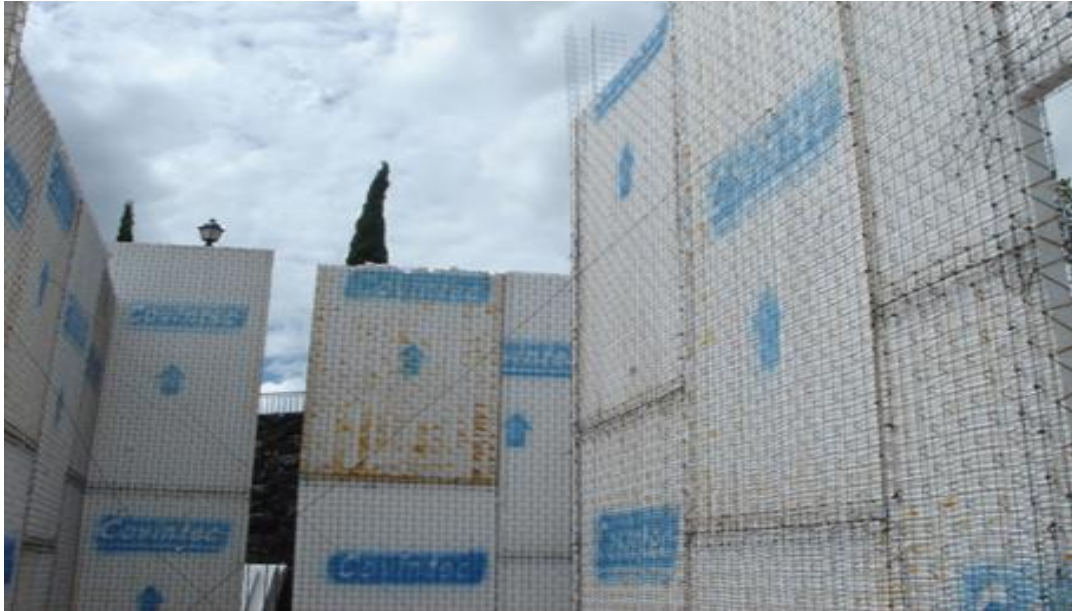
Figura No. 14. Preparación del muro para acabados.
