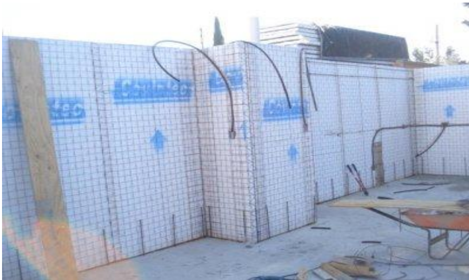
Figura No. 13. Estucado de bardas de una casa habitación.
