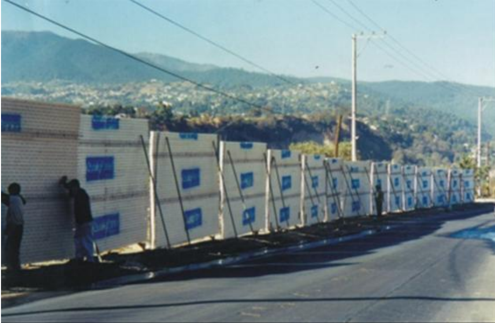
Figura No. 20. Muro acometida de predio particular.
