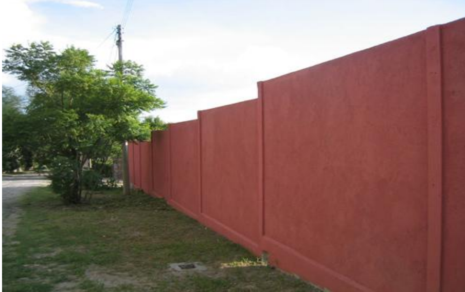
Figura No. 22. Vista final del muro acometida con sus acabados.
