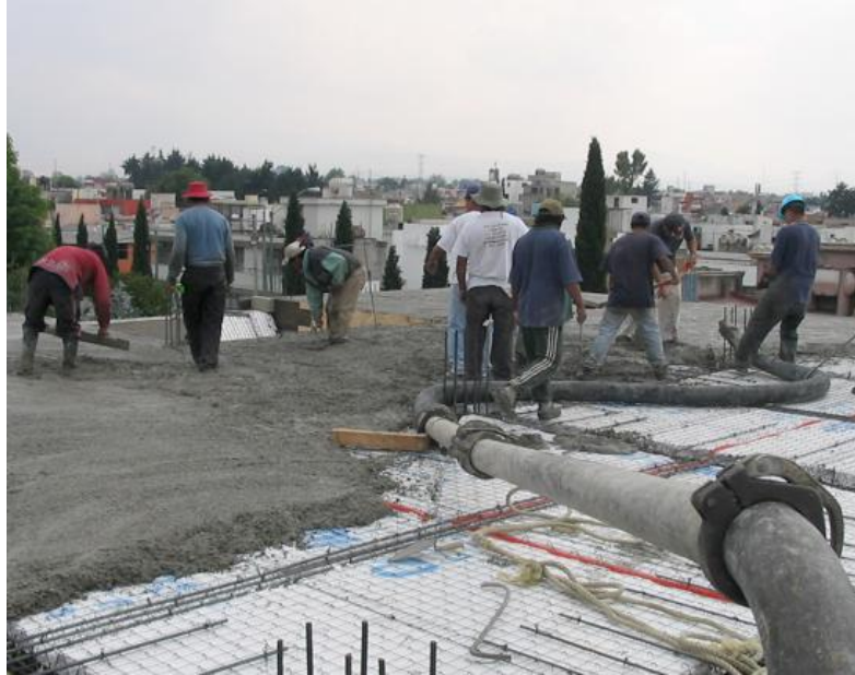
Figura No. 54. Colado de losa con panel Covintec.
