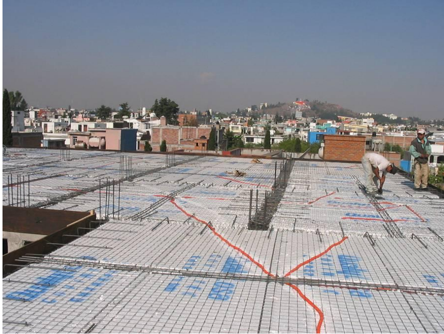
Figura No. 52. Vista del tendido de poliducto para instalaciones eléctricas, sobre la losa.
