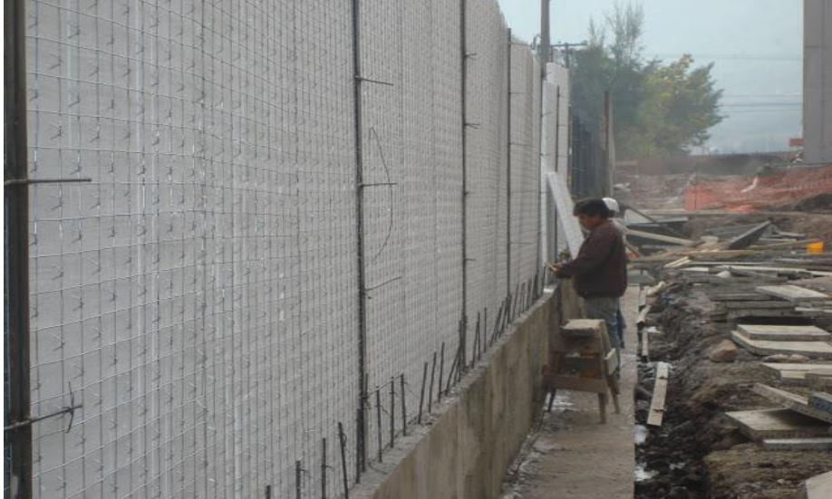
Figura No. 12. Estucado de una barda de lindero.
