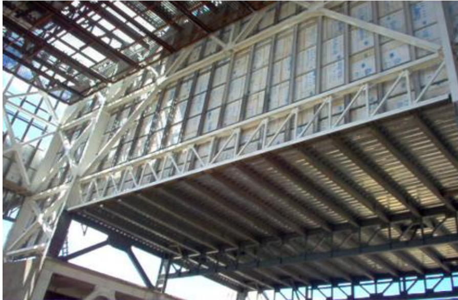
Figura No. 16. Vista de la utilización de panel covintec como muro divisorio sobre estructura metálica.
