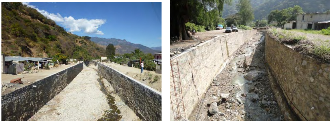
Figura 4.26 Canalización de los afluentes de la cuenca; río La Mina (izquierda) y Allende (derecha).
