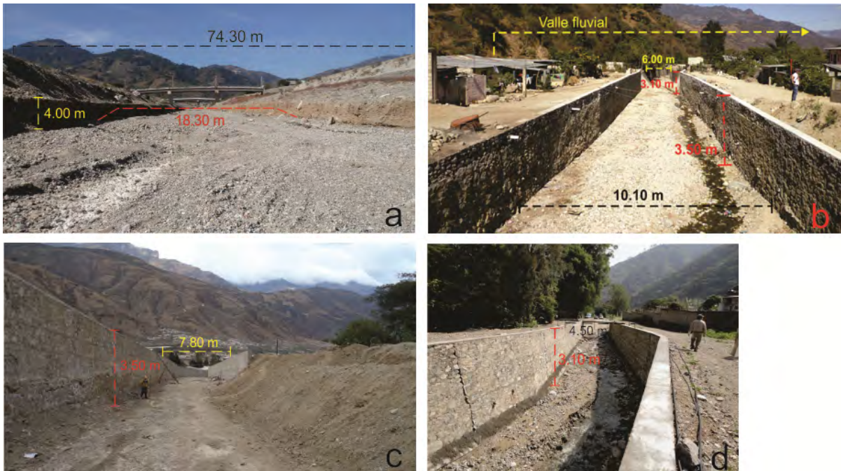
Figura 3.8. Se muestran la amplitud del río Xelajú y sus afluentes. a) El cauce principal del río Xelajú presenta terrazas fluviales; b) La Mina, se encuentra canalizado antes de entrar a la ciudad; c) En las márgenes del río Morelos la depositación sobrepasa los 2 metros de altura, debido al desbordamiento de materiales fluviales. Por esto mismo, la canalización está en construcción; d) Canalización del río Allende.
