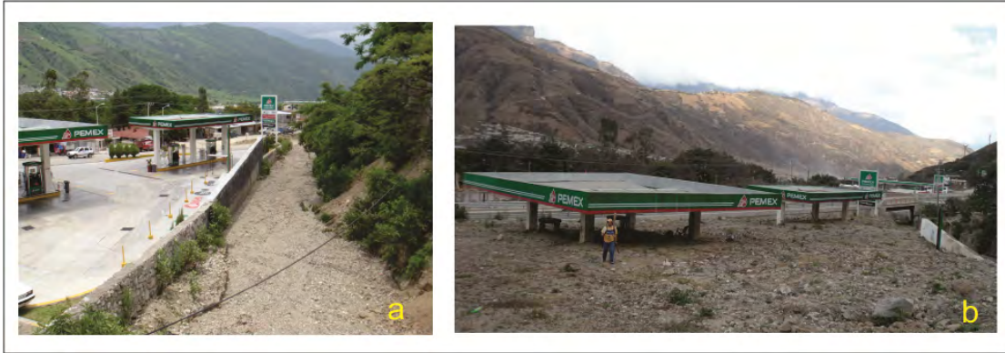
Figura 2.8. Gasolinera “Colosio” sepultada por el flujo de lodo del río Morelos; a) instalaciones antes del evento (4 de junio de 2010, cortesía de Manuel Figueroa), b) material acarreado por el río, espesor de 2.5 metros (1 de enero de 2012).
