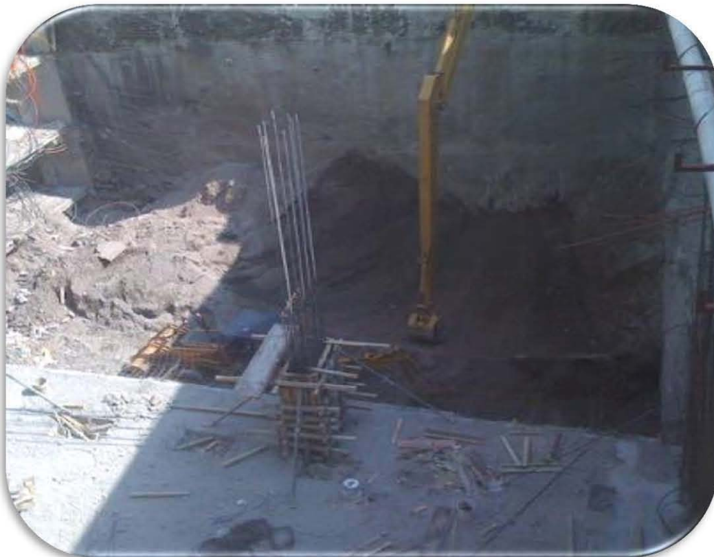
Figura 5.1 a3 Excavación de la zanja con retroexcavadora
