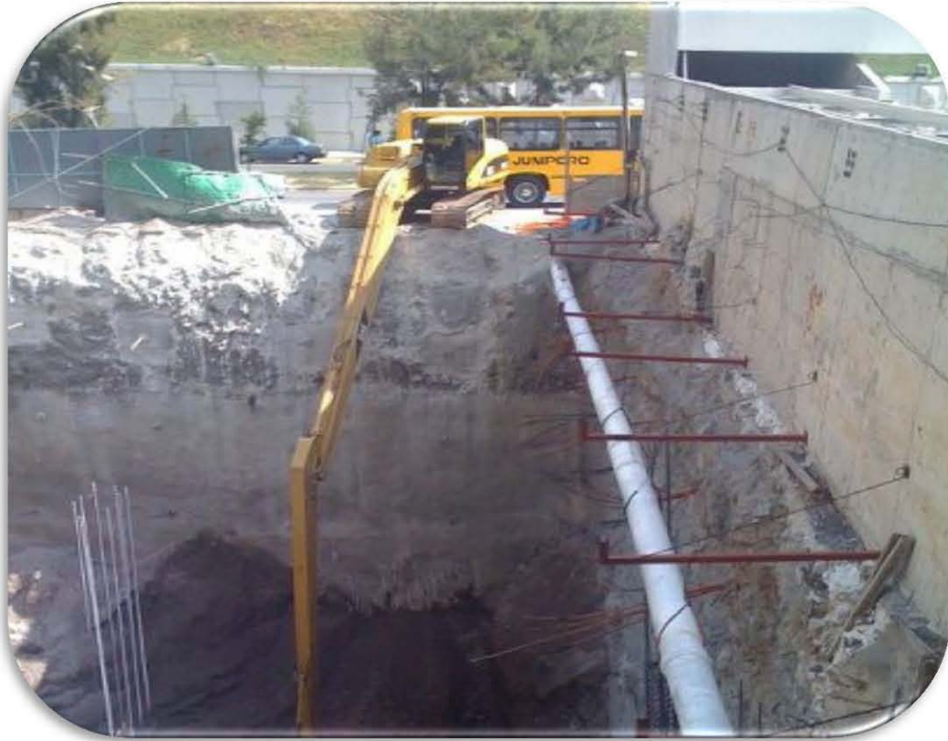
Figura 5.1 a2 Excavación de la zanja con retroexcavadora
