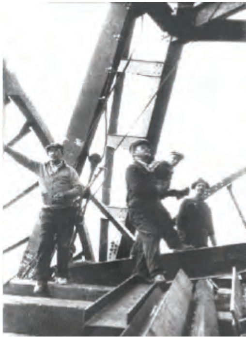
La estructura de acero
