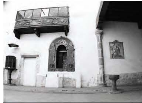
ACCESO SUR A CONVENTO (CERRADO)
