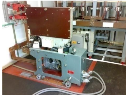
Figura. 2-25 Unipolar con cierre eléctrico y manual para un voltaje nominal de 800 Vcd y corriente de 6000 Amp. cd.
