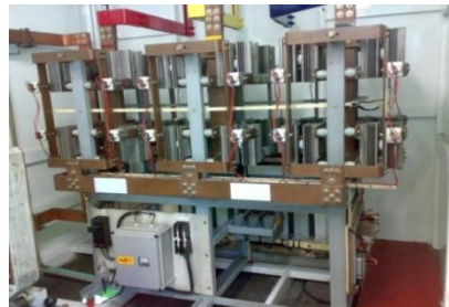
Figura. 2-13 Rectificador JEUMONT-SCHNEIDER de 6 pulsos.
