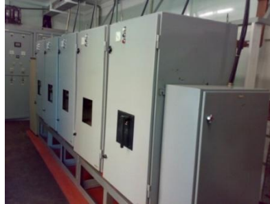
Figura. 2-27 Unipolares con cierre eléctrico y manual para un voltaje nominal de 800 Vcd y corriente de 4000 Amp. cd.
