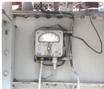
Figura. 3-8 Medidor de temperatura con zona.
