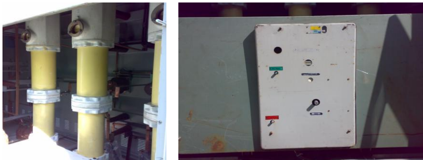
Figura. 3-2 Interruptor 52 piernas v mecanismo.
