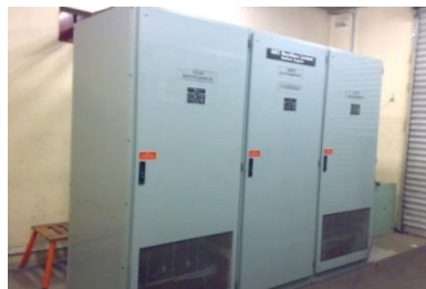
Figura. 2-15 Rectificador ENGLISH ELECTRIC 12 pulsos.
