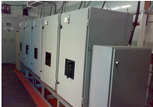
Figura. 3-11 Interruptores derivados.
