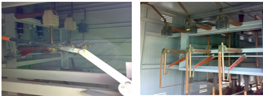
Figura. 3-1 Cuchillas 89AC conectadoras y desconectadoras.
