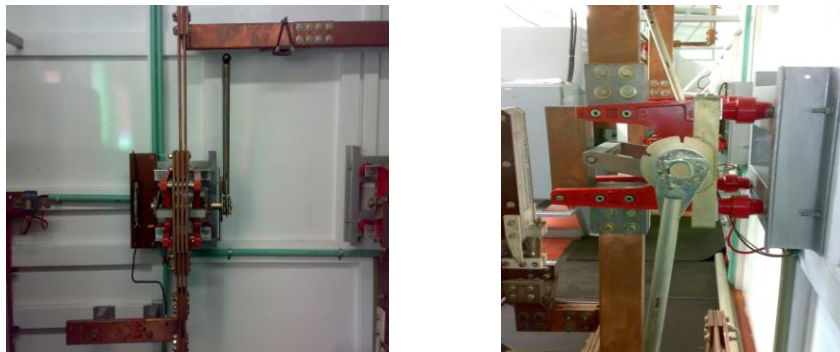
Figura. 3-10 Seccionadores 89N y 89P.
