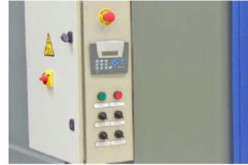
S-250 keyboard for drying process controlling. S-250 panel de control para el proceso de secado
