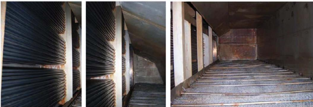
FIGURA 3. 30 Vista interna de una cámara de desalación de una planta MED [IMPU .SA, 2008]
