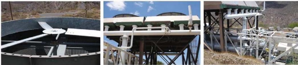
**FIGURA 3.11 Intercambiadores de calor de la planta geotérmica Tres Vírgenes.** De izquierda a derecha: A) Ventilador de la torre de enfriamiento seca, B) Torre de enfriamiento seca y C) Intercambiadores de calor tubulares. (IMPULSA IV, Instituto de Ingeniería UNAM, 2008)
