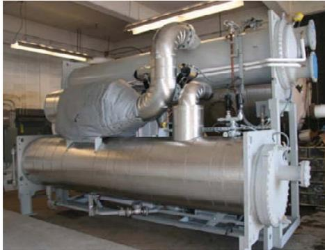
**FIGURA 3. 1** Unidad modular de un ciclo binario de 280 kW.
