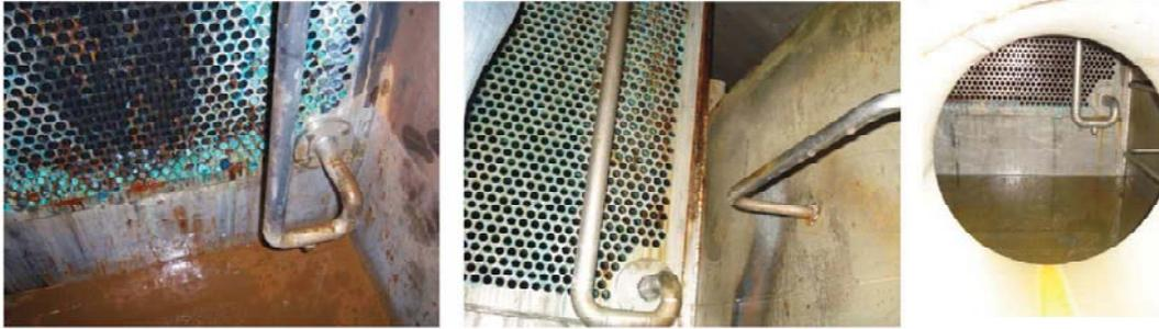
FIGURA 3. 28 Evaporador de la cámara desaladora MED [IMPULSA, 2008]
