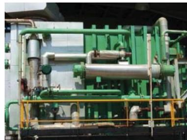
**FIGURA 3. 20** Sistema de vacío de la desaladora MED [IMPULSA, 2008]
