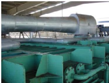
**FIGURA 3. 21** Sistema de calentamiento de la desaladora MED [IMPULSA, 2008]
