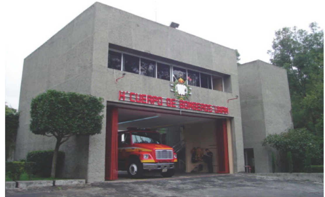
Foto 8 Fachada estación UNAM
