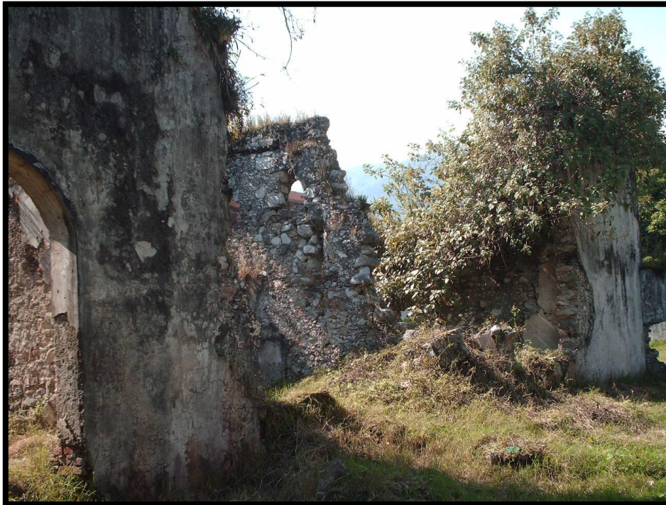
Foto 44. Interior de la Hacienda donde se observan parte de los patios, así como los muros ya colapsados por el paso del tiempo (Foto V. Francisco Heredia Guillén).
