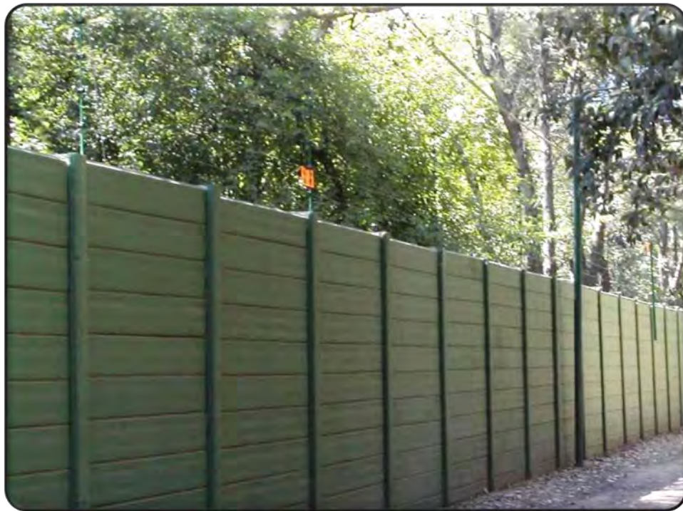
Fig. 3.11. Aplicación del BLOK en cercos.
