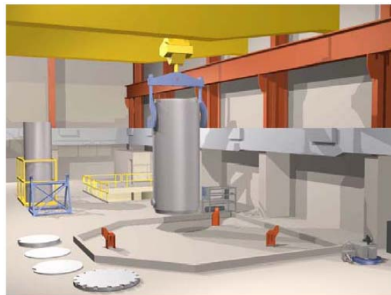
Figura 4-9. Movimiento del contenedor de transferencia/metálico al área de trabajo
