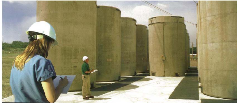
Figura 4-4. Contenedor de almacenamiento de tipo vertical
