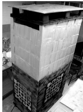
Figura 87 Esta caseta se construyó con envases de leche y bases de plástico.
