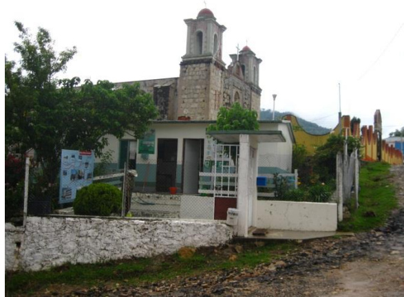
Figura 40 Fachada de la casa de salud de la comunidad.
