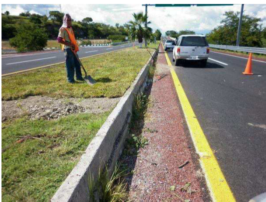
Fotografía No. 37 Vista antes de iniciar con las actividades de limpieza de guarnición.
