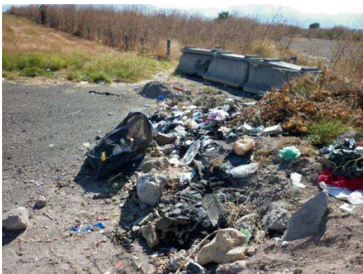
Fotografía No.10 Se observa la basura existente en el derecho de vía.
