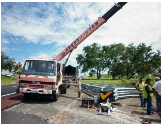
Fotografía No. 114 Se observa el entronque de con la Autopista Puente de Ixtla antes del suministro e instalación de 2 señales bandera doble
