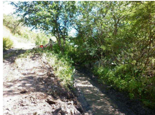
Fotografía No.67. Vista después de realizados los trabajos de desazolve de canales de entrada y salida.
