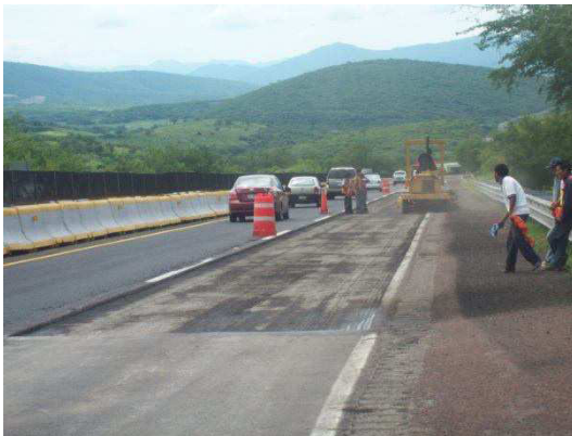
Fotografía No.4 Se observa zona donde se realizara el bacheo superficial
