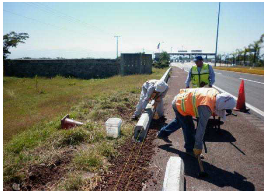
Fotografía No.41. Se observa a personal de la empresa contratista realizando el suministro y colocación de guarniciones prefabricadas de concreto hidráulico.
