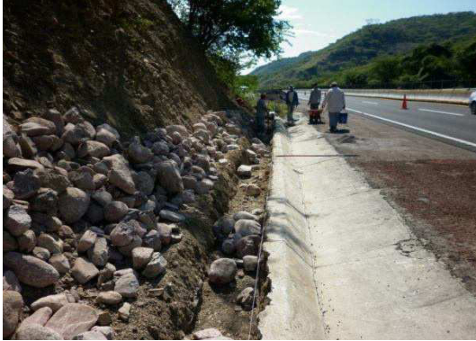
Fotografía No. 63 Se observa el sitio donde se realizara la reparación del muro de mampostería.
