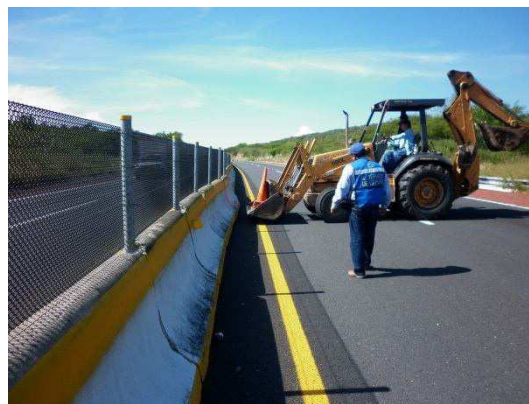
Fotografía No. 90. Vista durante la alineación de la barrera central.
