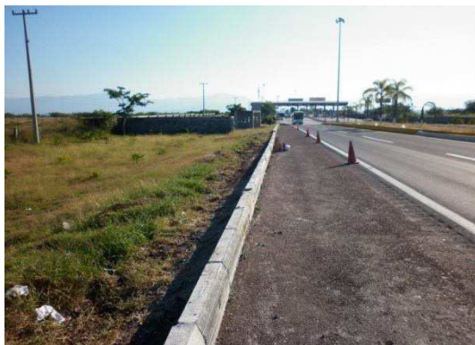
Fotografía No. 42 Vista después de terminados los trabajos de limpieza de guarnición.
