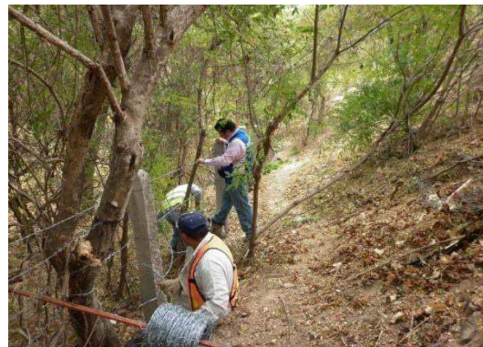
Fotografía No.23. Se observa a personal de la empresa contratista habilitando el alambre de púas en el cercado que delimita el derecho de vía.
