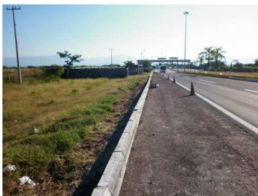
Fotografía No. 45 Vista después de terminados los trabajos de Alineación, renivelación y junteo de guarnición prefabricada de concreto hidráulico existente.
