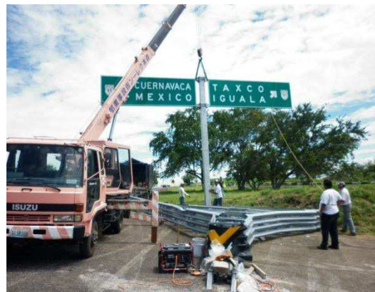
Fotografía No. 115. Se observa a personal de la ejecutora realizando la colocación de la señal tipo SID-14
