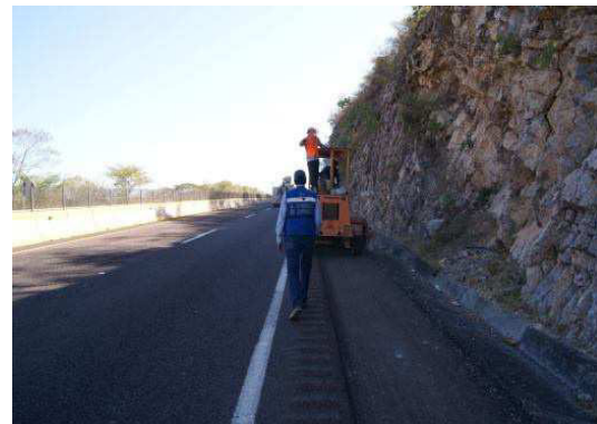
Fotografía No.2. Se observa la barredora realizando el retiro de basura del acotamiento.
