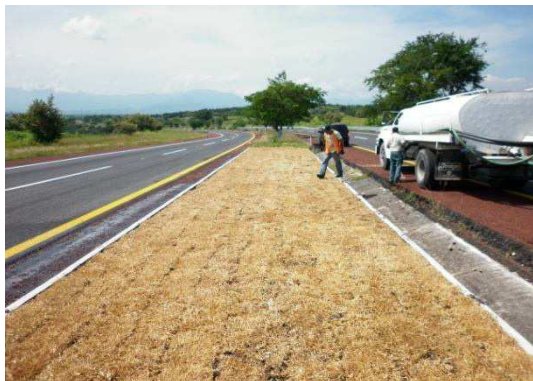
Fotografía No. 49 Vista antes de iniciar con el riego de zonas jardinadas.
