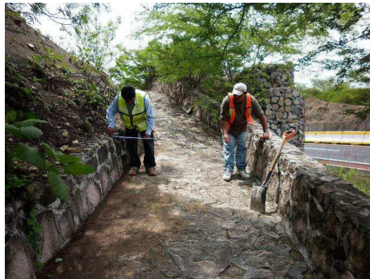
Fotografía No. 70 Se observa materia a personal de la Supervisión realizando la medición de la superficie limpiada.
