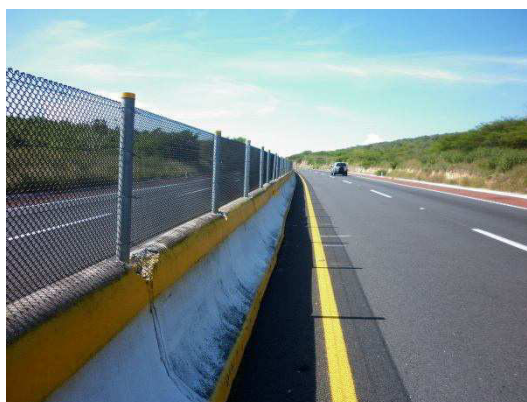
Fotografía No. 91 Vista una vez alineada la barrera central.
