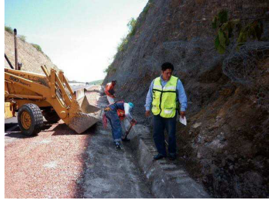
Fotografía No.81. Se observa a personal de la empresa contratista realizando la remoción de material acumulado.
