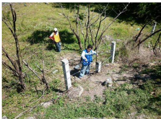
Fotografía No.21 Se observa a personal de la supervisión realizando la verificación del tensado del alambre.
