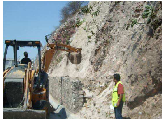
Fotografía No.75. La empresa contratista se auxilió con una retroexcavadora para realizar la remoción de material en muro alcancía.
