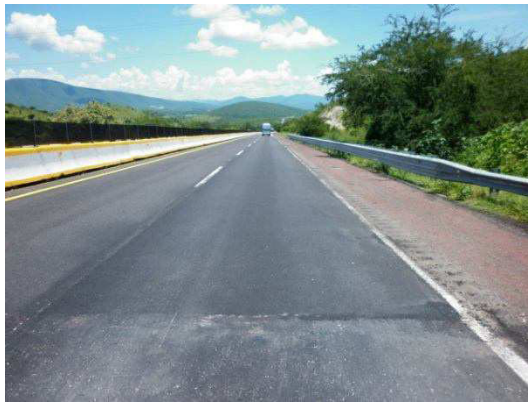
Fotografía No.6 Vista después del bacheo superficial.
