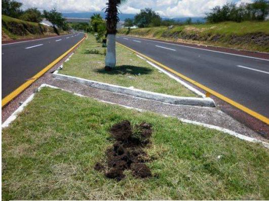
Fotografía No. 31 Se observa el sitio del camellón central antes de la siembra de árboles.
