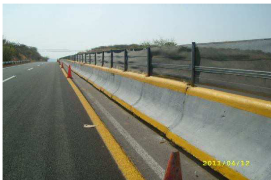
Fotografía No. 95 Tramo antes de iniciar los trabajos de aplicación de pintura en franjas de barrera central.
