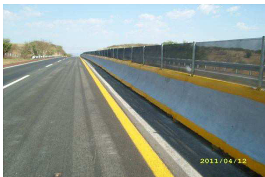
Fotografía No. 97 Vista después de la aplicación de pintura en franjas de barrera central.
