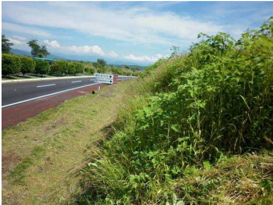
Fotografía No. 34 Vista antes de iniciar el deshierbe de taludes.
