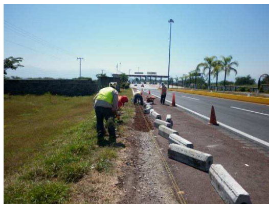
Fotografía No.44. Una vez nivelado y alineado el personal de la contratista procede a la rehabilitación de dichos elementos..
