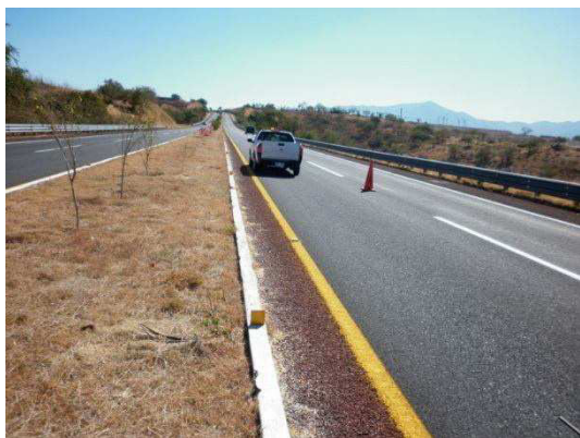
Fotografía No. 104 Vista de tramo antes de iniciar los trabajos de suministro y aplicación de pintura amarilla en rayas continuas.
