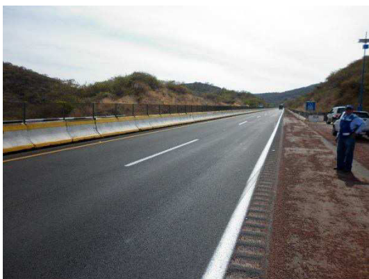
Fotografía No. 98 Vista de tramo antes de iniciar los trabajos de suministro y aplicación de pintura blanca en rayas discontinuas
