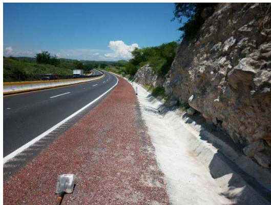
Fotografía No. 59 Vista después de terminados los trabajos de limpieza de cunetas
