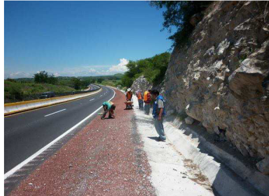
Fotografía No.58. Vista durante barrido y limpieza de cunetas.
