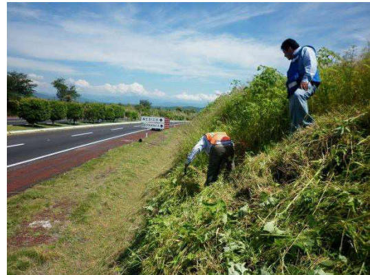
Fotografía No.35. Se observa a personal de la empresa contratista realizando el deshierbe de taludes por medios manuales.
