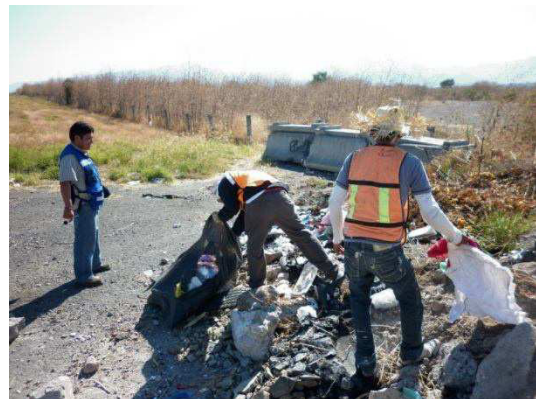
Fotografía No.11. Se observa a personal de la empresa contratista realizando la recolección, pepena y retiro de basura del derecho de vía
