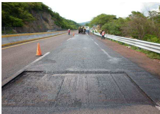
Fotografía No. 111 Se observa riego de impregnación en el cajón realizado para el inicio de la renivelación.
