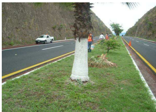
Fotografía No.30 Vista una vez realizados los trabajos de pintado de árboles en camellón central.
