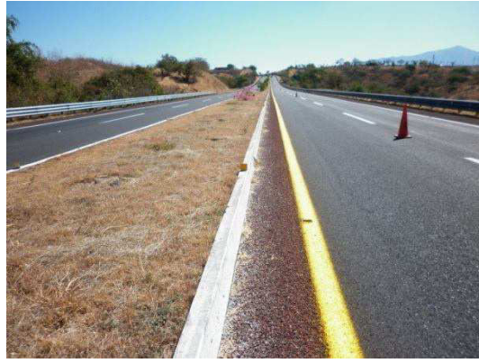
Fotografía No. 106. Vista después de realizados los trabajos de suministro y aplicación de pintura amarilla en rayas continuas.
