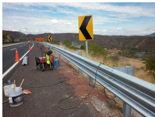
Fotografía No. 94. Vista una vez terminado el suministro y colocación de defensa metálica de tres crestas.
