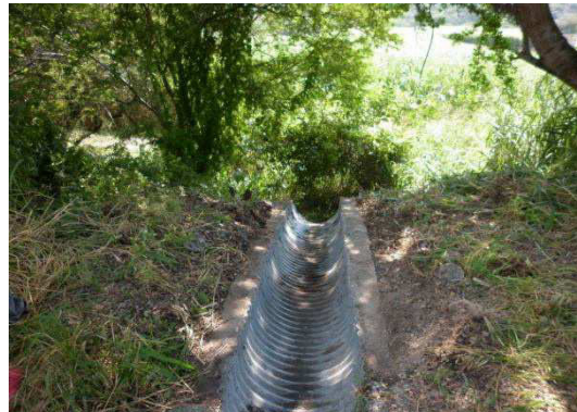
Fotografía No.62. Vista después de realizados los trabajos de limpieza y desazolve de lavaderos.
