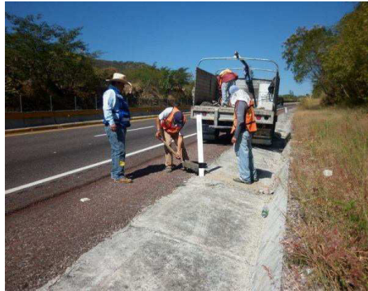
Figura No. 118, se observa a personal de la supervisión realizando la inspección y verificación del relleno con concreto hidráulico del indicador de alineamiento vertical.
