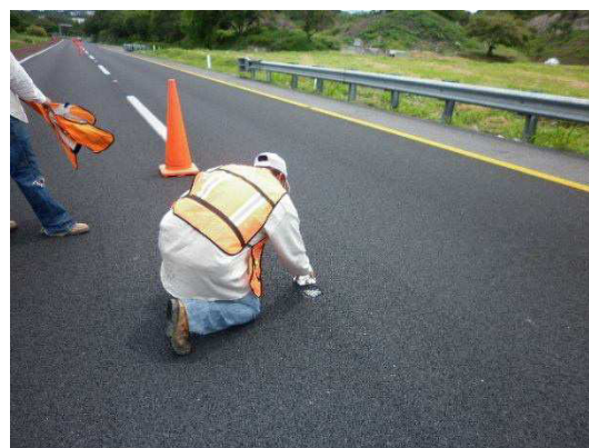
Fotografía No.84. Se observa a personal de la empresa contratista realizando la colocación de vialeta blanca.
