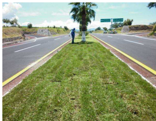
Fotografía No.52. Vista después de la colocación de pasto en sección de camellón central.
