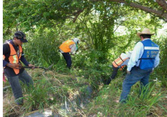
Fotografía No.61. Se observa a personal de la contratista realizando la limpieza y desazolve de lavaderos.
