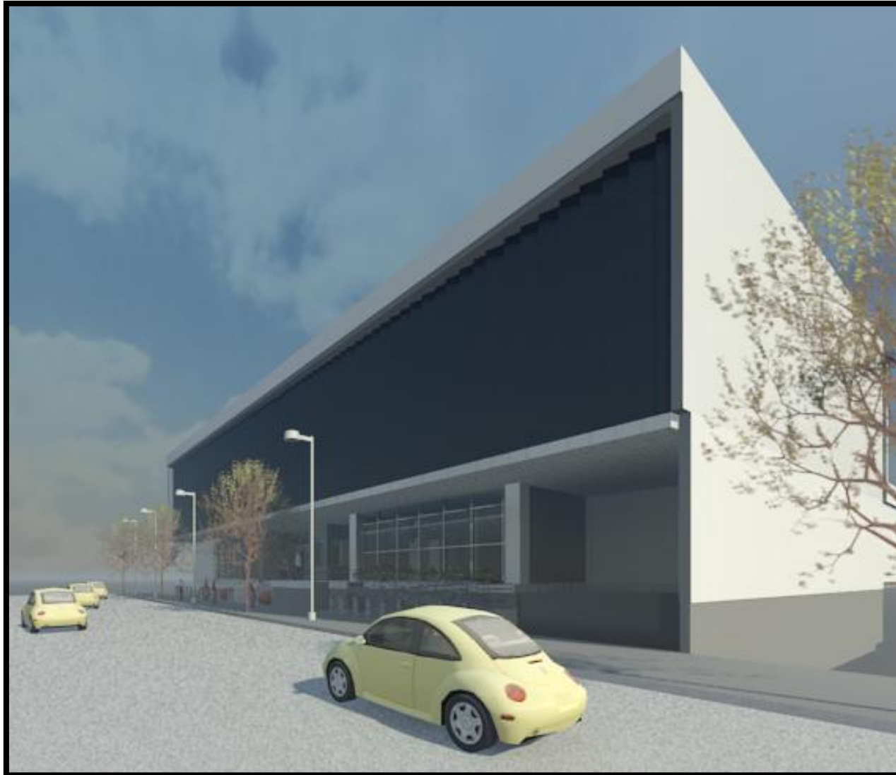
Imagen No 4 Fachada Principal en la avenida José María Castorena.
