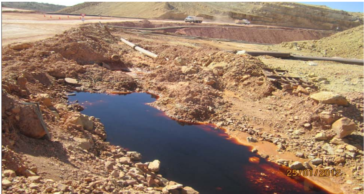
Imagen 19: Termina el canal excavado de sección trapecial 2.00 X (h variable), inicio de la alcantarilla AP-1, Cadenamiento 01+ 455.
