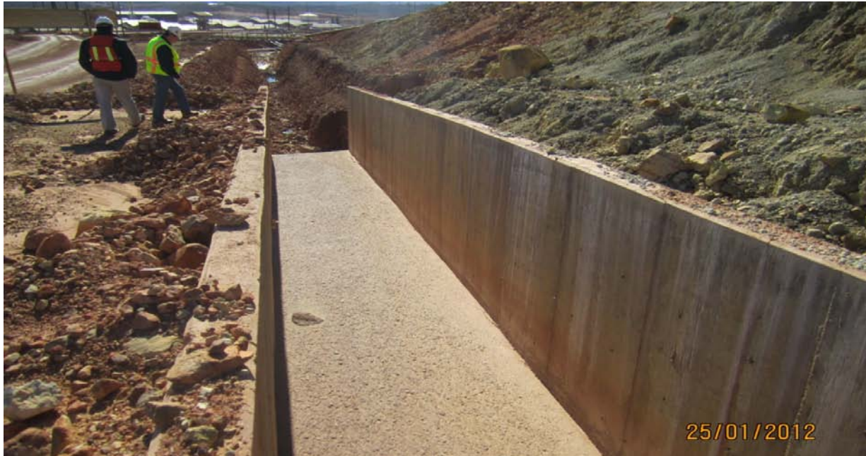
Imagen 13: Termina canal de concreto existente, Cadenamiento 00+ 707.
