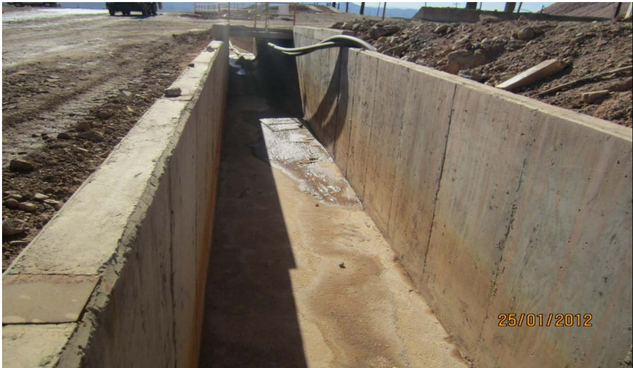
Imagen 7: Segundo cruce de camino, sección cajón 2.00 X (h variable) (m), Cadenamiento 00+ 330.
