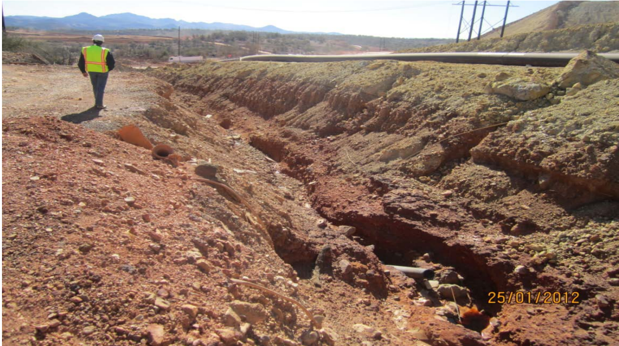
Imagen 18: Canal excavado de sección trapecial 2.00 X (h variable), Cadenamiento 01+ 380.
