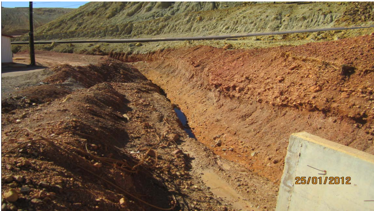
Imagen 17: Canal excavado de sección trapecial 2.00 X (h variable), Cadenamiento 01+ 280.
