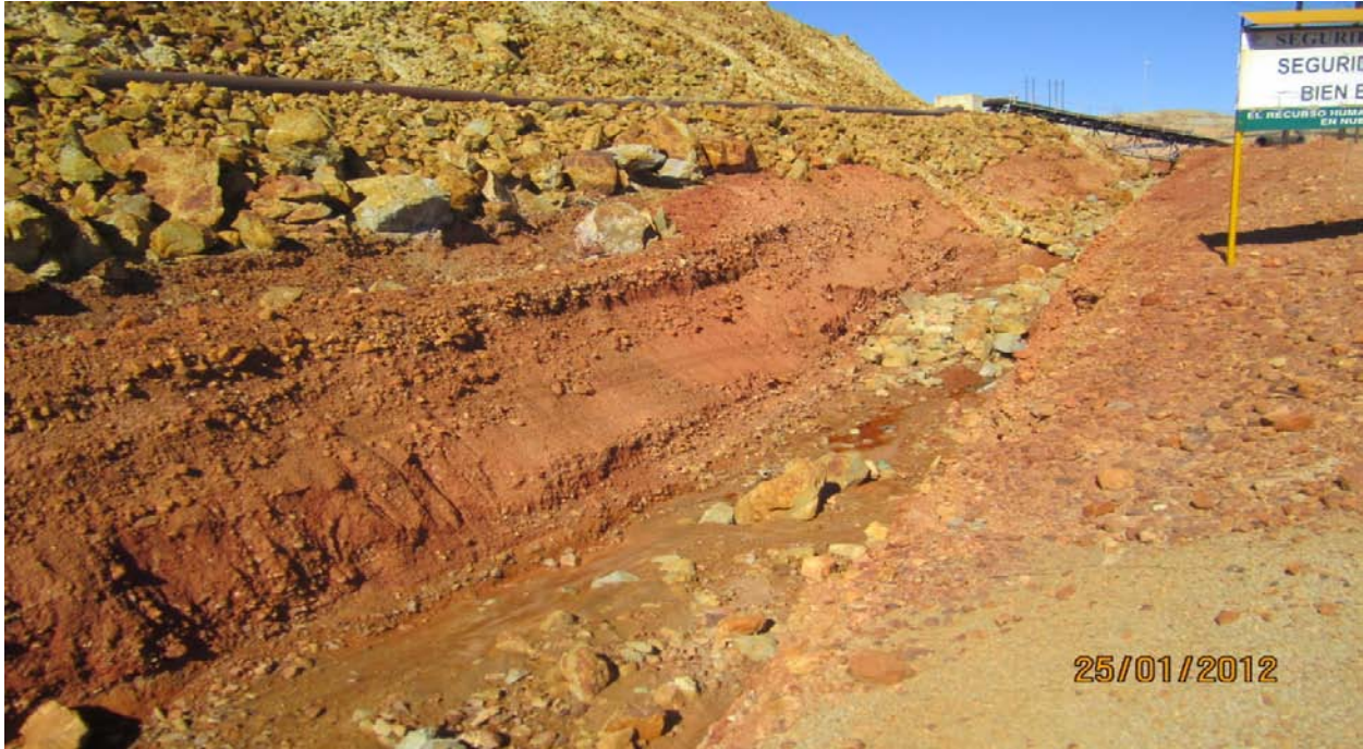
Imagen 16: Canal excavado de sección trapecial 2.00 X (h variable), Cadenamiento 01+ 175.
