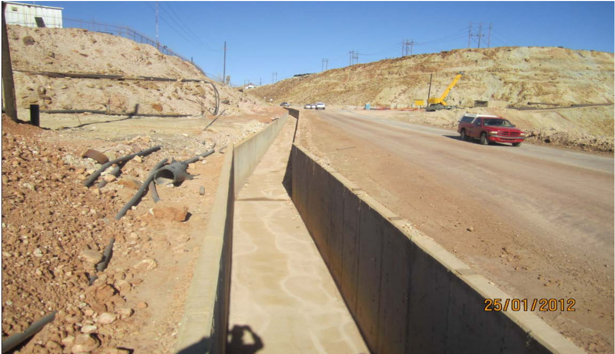
Imagen 5: Canal de concreto sección 2.00 X 1.80 (m), Cadenamiento 00+ 240.
