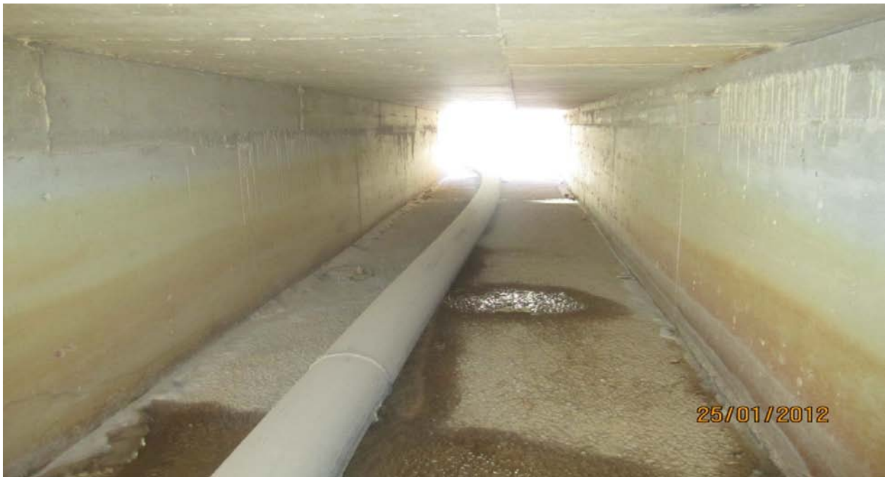
Imagen 2: 1er cruce de camino sección cajón de concreto 2.00 X 1.56 (m), Cadenamiento 00+ 055.
