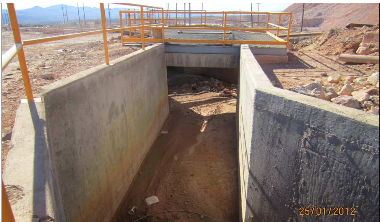
Imagen 8: Caja vertedora, sección 420 X 3.09 (m), Cadenamiento 00+ 355.
