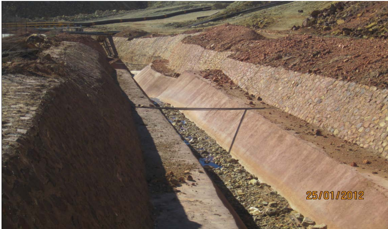
Imagen 14: Canal zampeado de sección trapecial compuesta, Cadenamiento 00+ 890.
