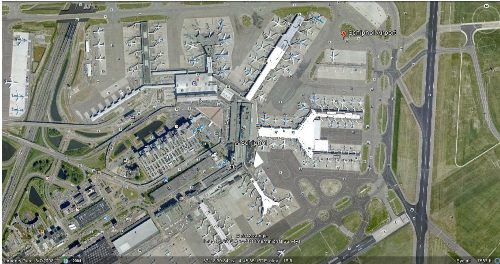
Terminal Muelle. Aeropuerto de Amsterdam Schiphol. (AMS). (Fig. 6)
