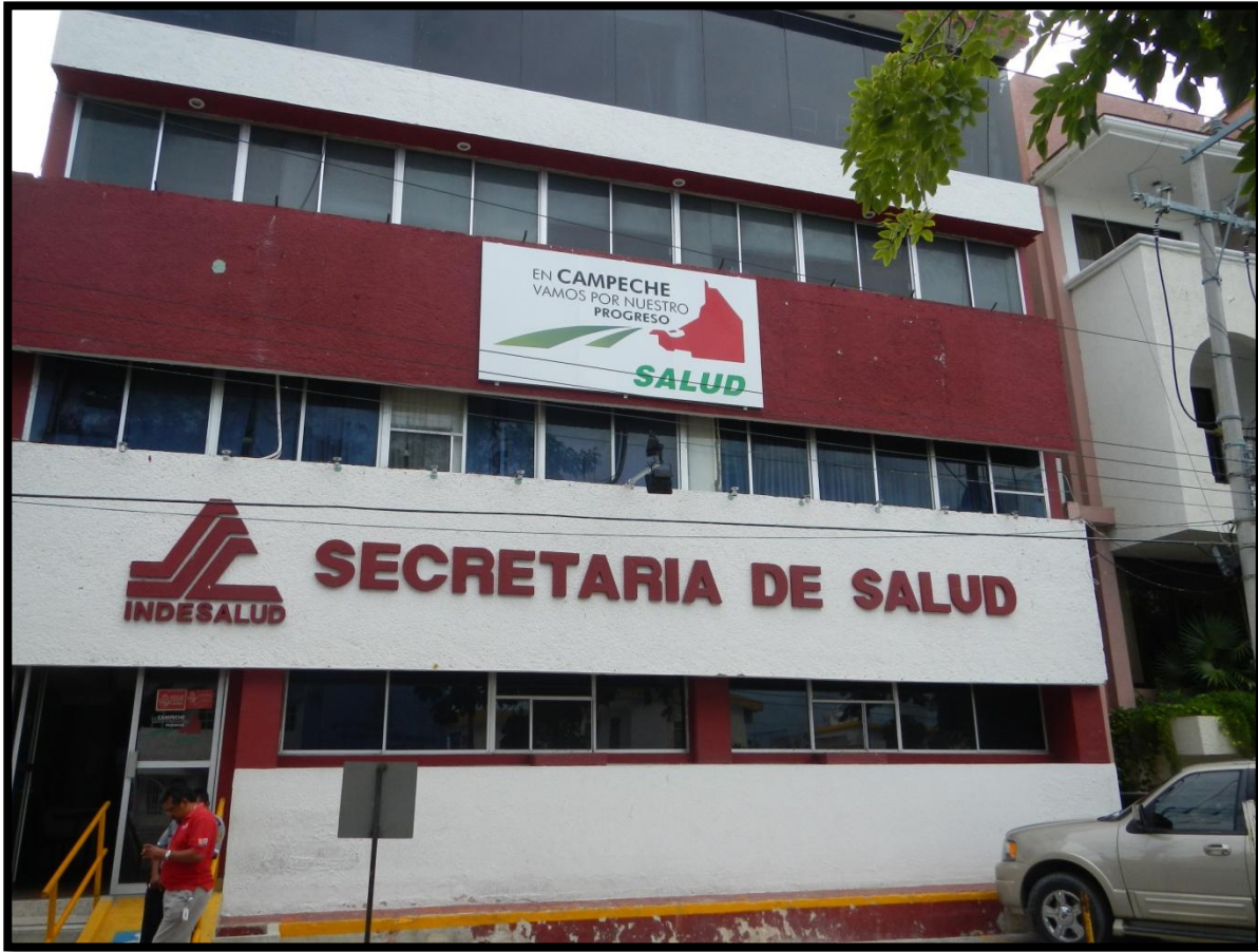
Figura 4.8 Edificio de la Secretaría de Salud del estado de Campeche
