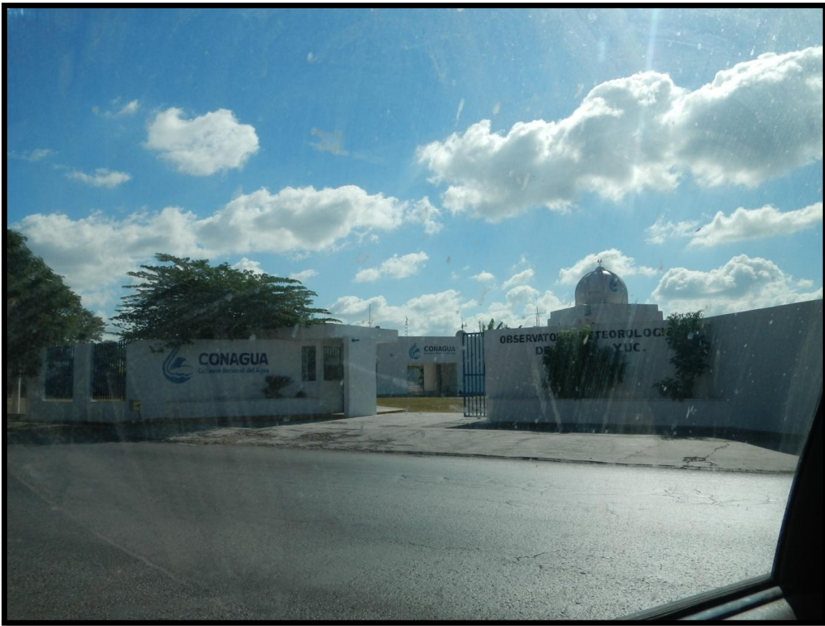
Figura 4.3 Fachada exterior del Observatorio Meteorológico de Mérida, Yucatán.
