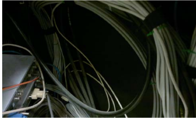
Fig. 3.31 Amarre de cables
