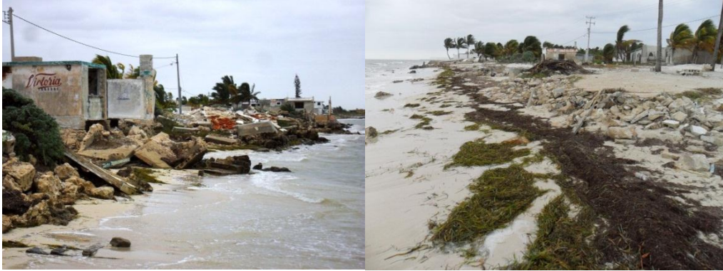
Figura 21. Alcance de la erosión costera en la zona de residencias y negocios de la costa de Yucatán.
