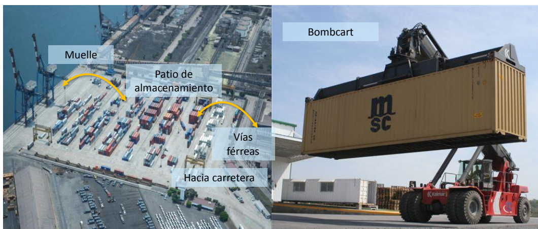
Figura 16. IZQUIERDA. Transferencia de la carga del muelle al patio de almacenamiento, y de este hacia la zona de acopio para el transporte terrestre. DERECHA. Grúas tipo Bombcart 25 utilizadas para realizar el transporte de los contenedores dentro de la terminal portuaria. Elaboración propia con fotos tomadas en el Puerto de Lázaro Cárdenas.
