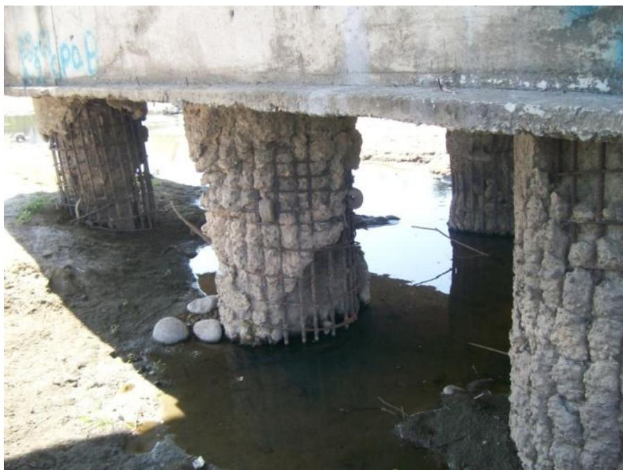
**Figura 7. Exposición de la cimentación del puente Pijijapan I**
