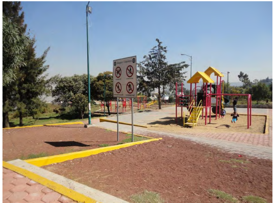
Construcción de la Preparatoria y Parque Corrales remodelado.
