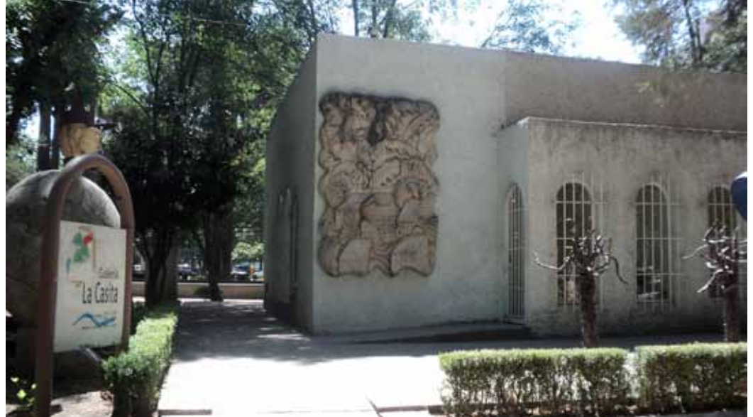
Fachada de la galería “La Casita”.
