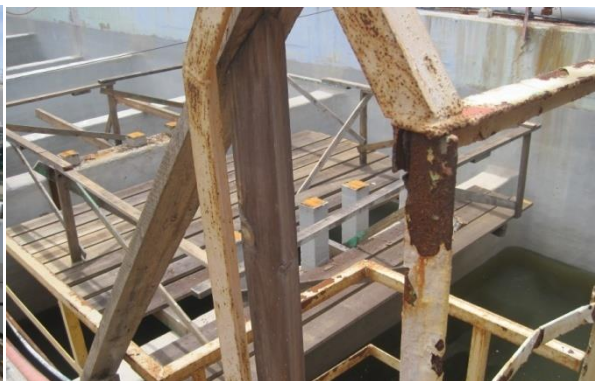
Figura 12. Estructura del barandal.
