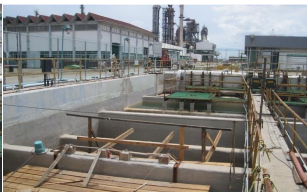
Figura 14. Mantenimiento de la Fosa de Neutralización.
