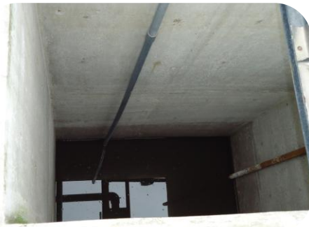
Acondicionamiento de lodos
