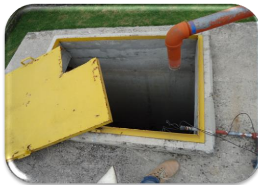
Cisterna de agua tratada
