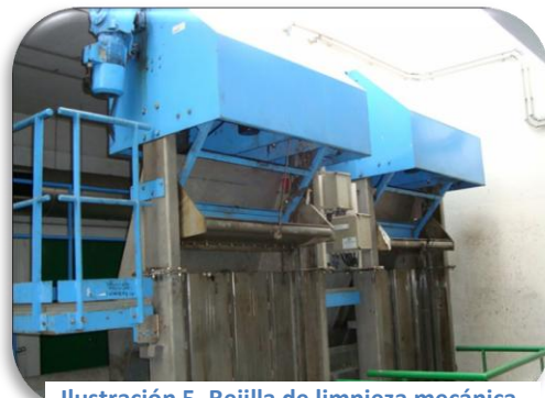
Ilustración 5. Rejilla de limpieza mecánica.
