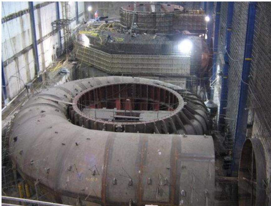
**Figura I.1 Turbinas tipo Francis en proceso de instalación.**
