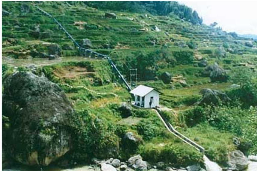
**Figura I.7 Miniproyectos hidroeléctricos: Sobre la margen de una corriente y en el extremo de una tubería a presión.**
