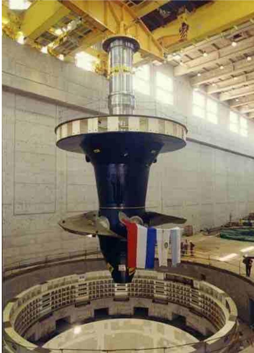
**Figura I.4 Turbinas tipo Kaplan.**
