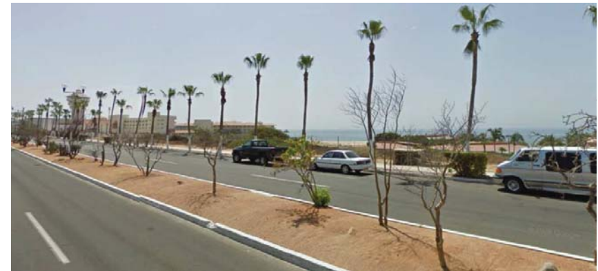
Vista 3- Acceso al predio Av. Paseo Malecón San José
