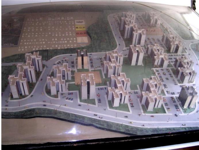
La unidad tiene 29 edificios: 13 edificios de 10 pisos y 16 edificios de 5 pisos, todos con cuatro departamentos por planta. Foto maqueta de archivo de la autora.
