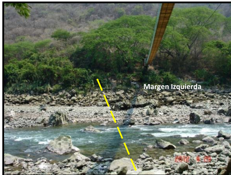
Fotografía 13. Se ilustra aproximadamente la zona donde se empotrará la ataguía de aguas arriba en la margen izquierda.
