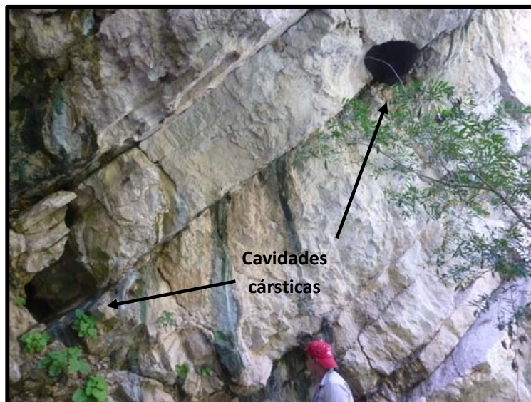
Fotografía 9. Cavidades cársticas en planos de estrato de aproximadamente 0.5 m de diámetro. Margen Izquierda, aguas abajo del sitio de cortina del P. H. Chicoasén II.
