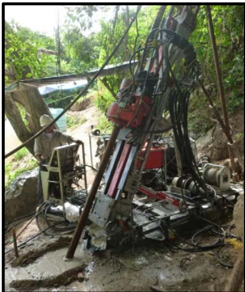
Fotografía 10. Equipo para la perforación de barrenos.
