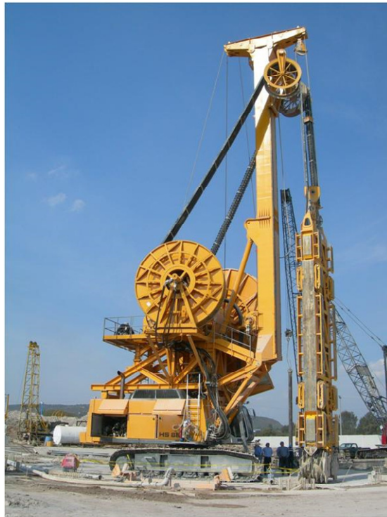
Figura B.1.36. Hidrofesa empleada en la excavación para la construcción de Muros Milán de lumbreras profundas
