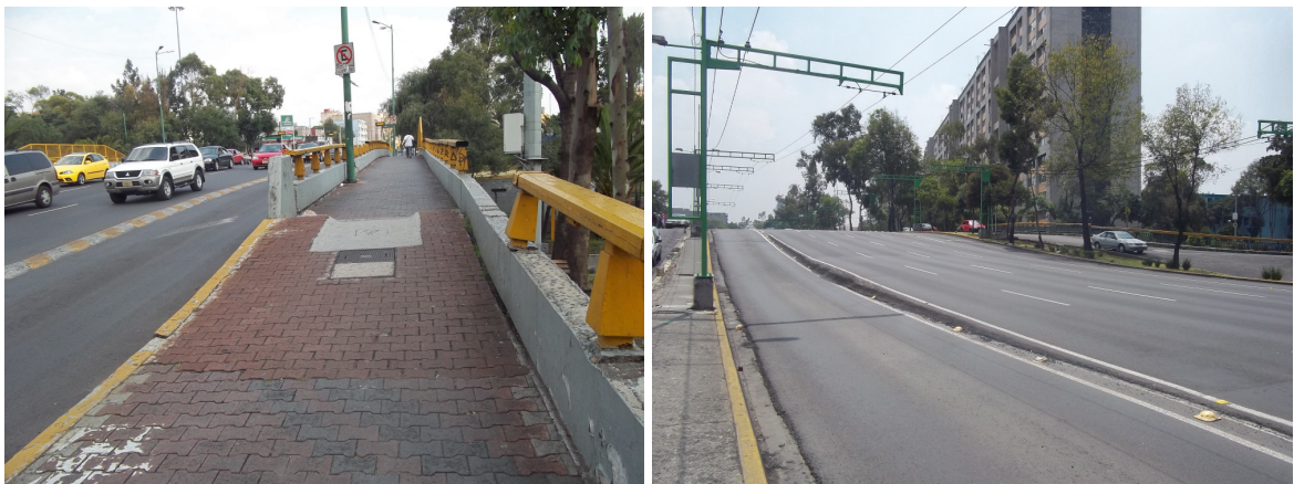
Figura B.1.59. Reparaciones emergentes para mitigar el impacto del hundimiento regional en obras viales
