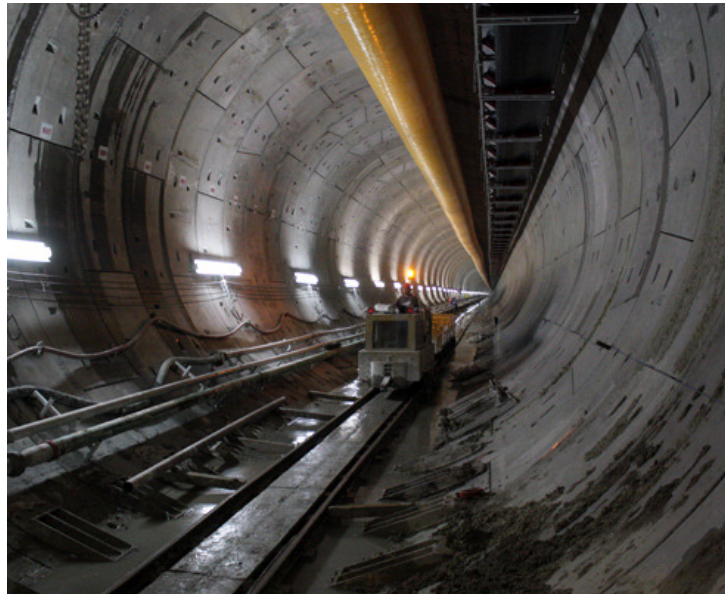
Figura B.1.13 Interior del Túnel Emisor Oriente de la ciudad de México, actualmente en construcción
