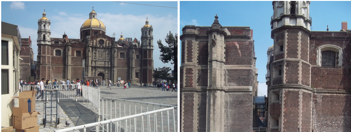
Figura B.1.56. Daños generados en la antigua Basílica de Guadalupe, influencia del cerro del cerro del Tepeyac y el hundimiento regional
