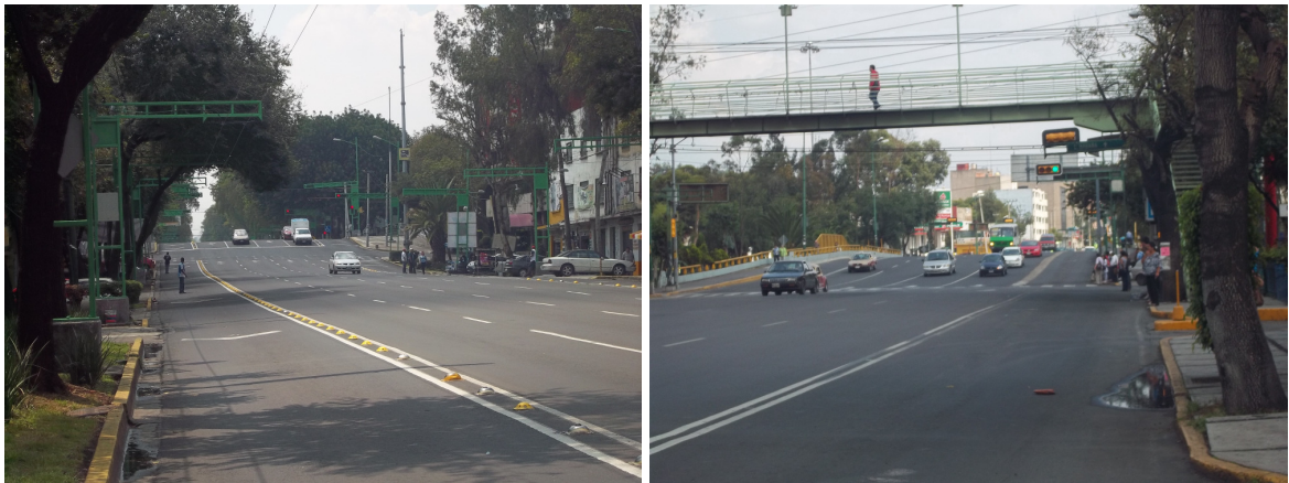
Figura B.1.58. Modificación de avenidas generada por el hundimiento regional
