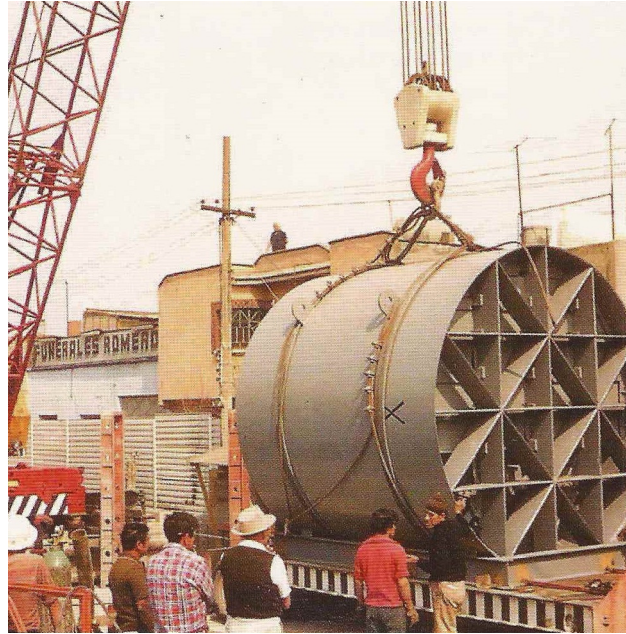
Figura B.1.11 Escudo con rejilla empleado durante la construcción del Emisor Central de la ciudad de México
