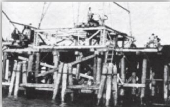
Figura 2. Vista cercana de una plataforma de madera, una milla costa afuera de la playa de McFaddin, Texas, en 1938. (Fuente: Conceptos básicos de Ingeniería Civil Costa Afuera, Tomo I.)
