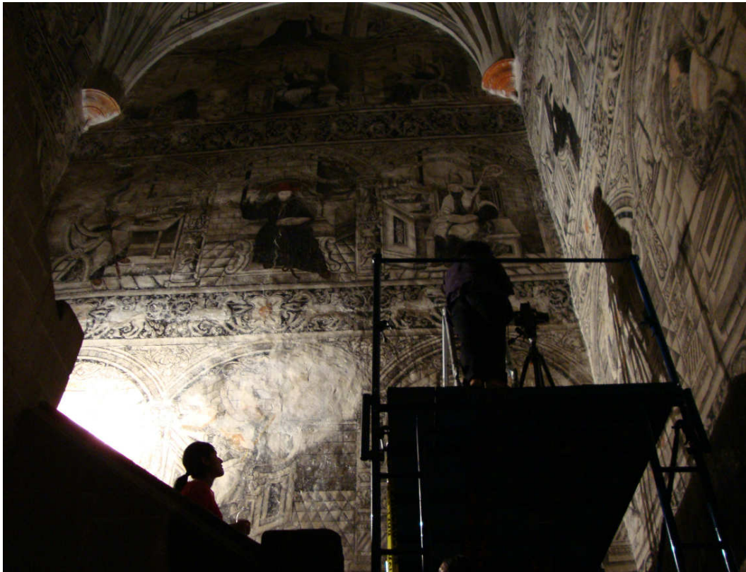
Imagen 6.7. Fotografía, armando andamios en el cubo de la escalera
