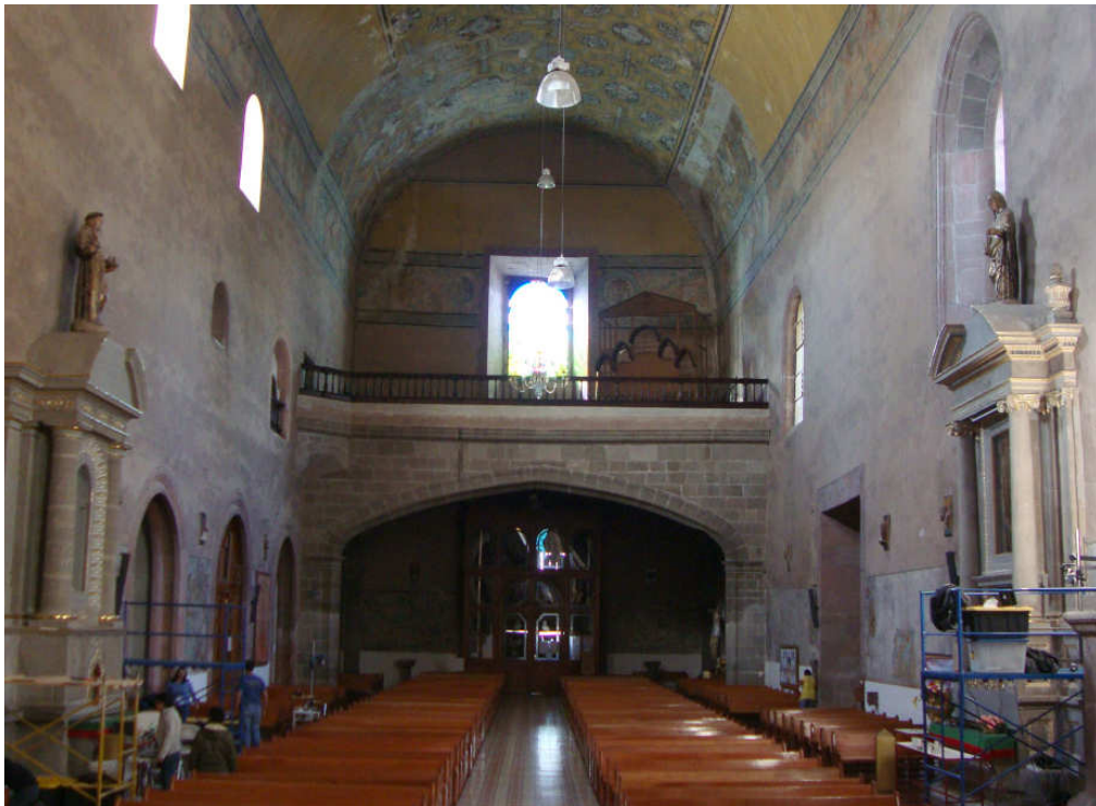
Imagen 6.8. Fotografía, andamios y equipos en la nave principal de Ixmiquilpan
