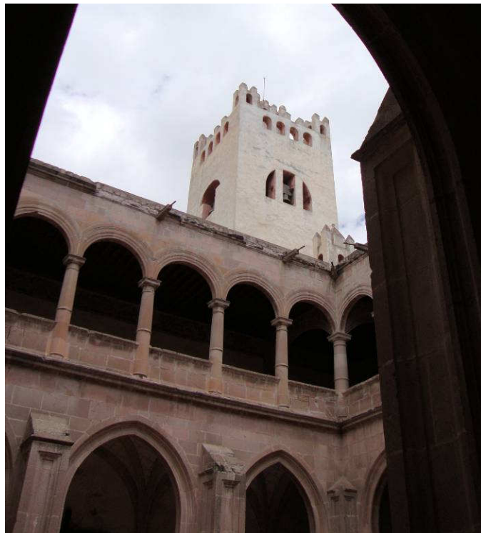
Imagen 2.5. Fotografía del claustro y almena del ex convento de San Nicolás Tolentino, Actopan, Hidalgo.
