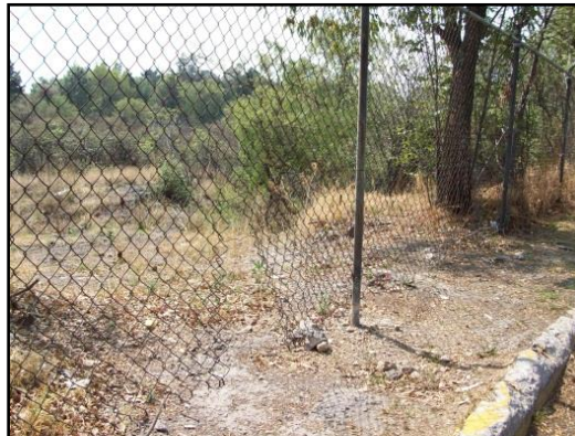
Figura 10. Malla ciclónica rota en estacionamiento
